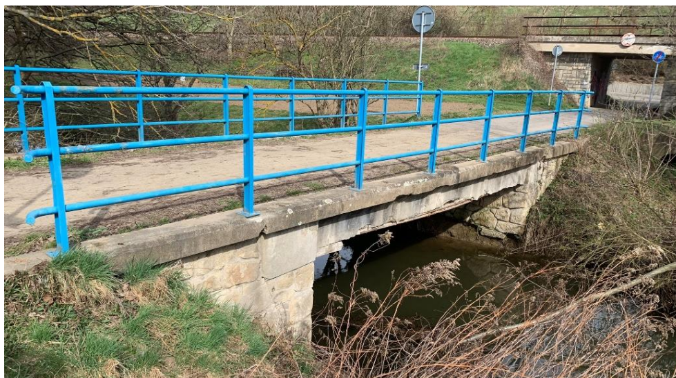
Obr. 48 Most M01, ř. km 1,035 [autor]
