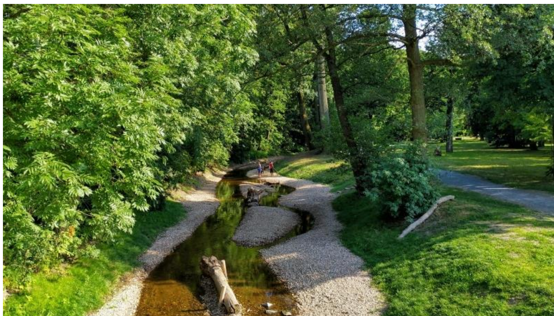
Obr. 64 Příklad koryta při malém průtoku (Revitalizace náhonu v Chrudimi) [54]
