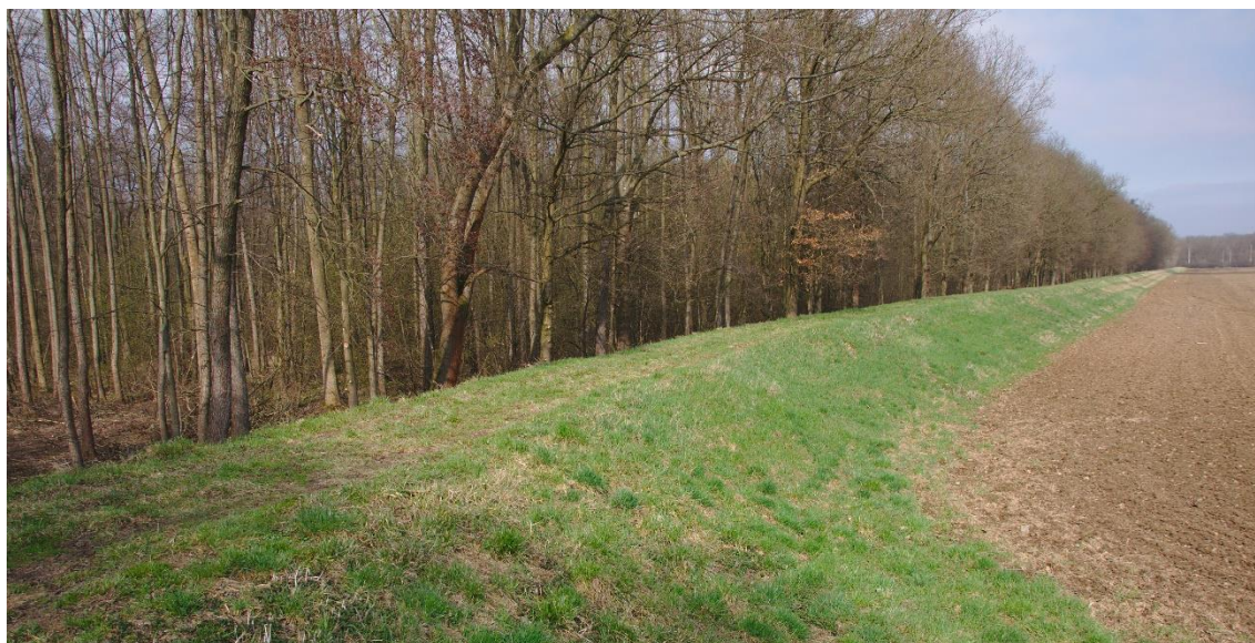
Obr. 68 Příklad protipovodňové hráze [58]
