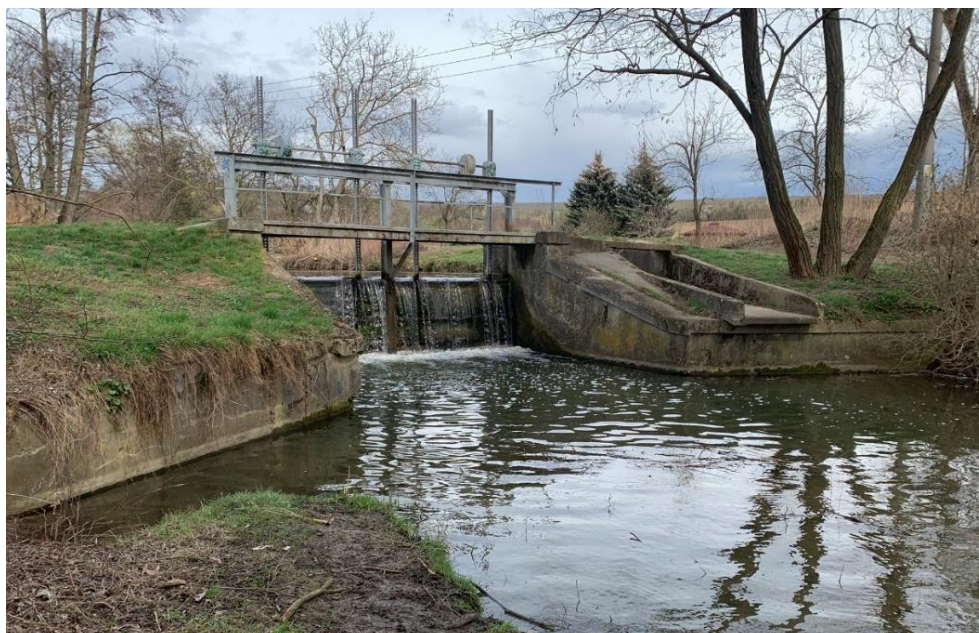
Obr. 50 Jez, ř. km 0,633 [autor]
