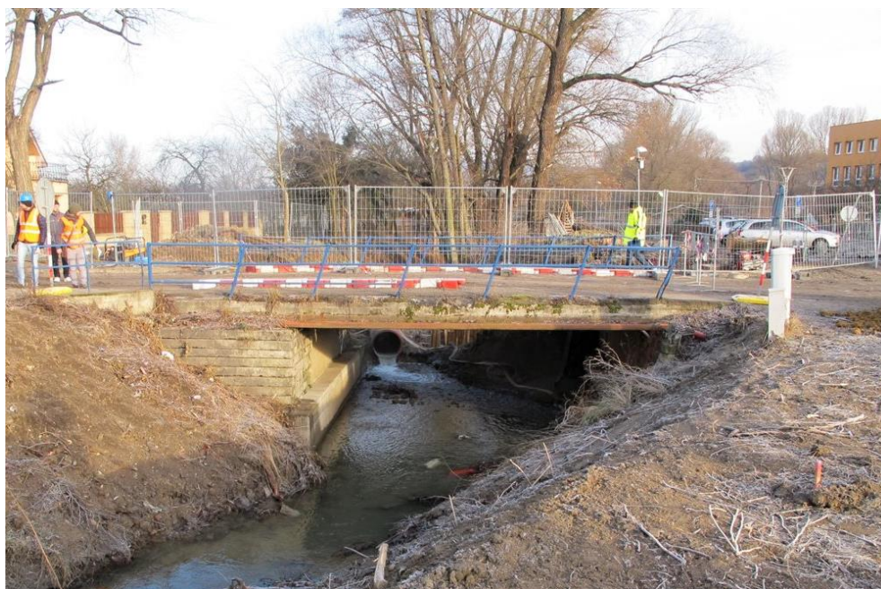
Obr. 51 Původní most M02, ř. km 0,384 [47]
