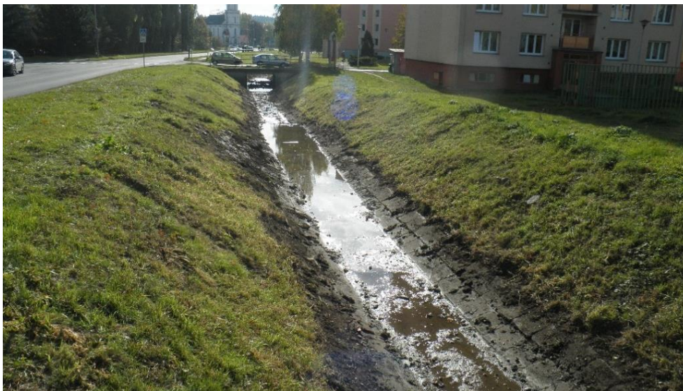
Obr. 22 Původní opevněné koryto Kobylí potok [13]
