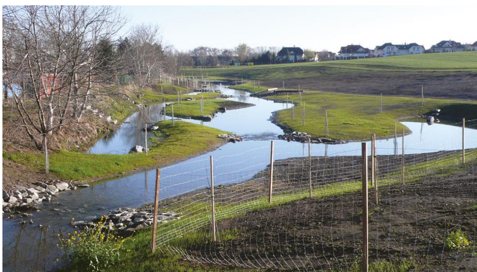
Obr. 21 Výsledek revitalizace Litovického potoka [11]
