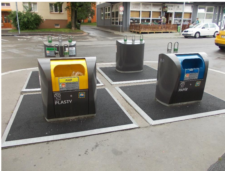
Obr. 7: Podzemní kontejnery na separovaný odpad [18]
