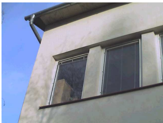
Obr. 26 Pohled na jihozápadní stěnu
