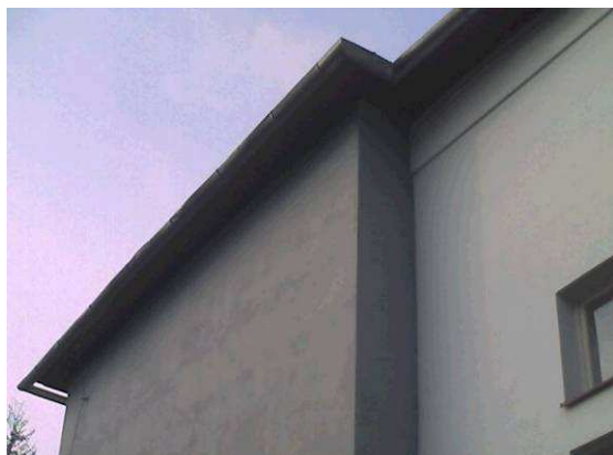
Obr. 24 Pohled na stěnu – jihovýchodní stěna
