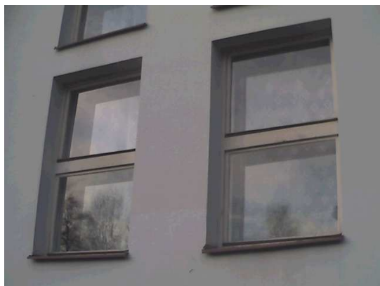
Obr. 22 Pohled na okna – jihovýchodní stěna
