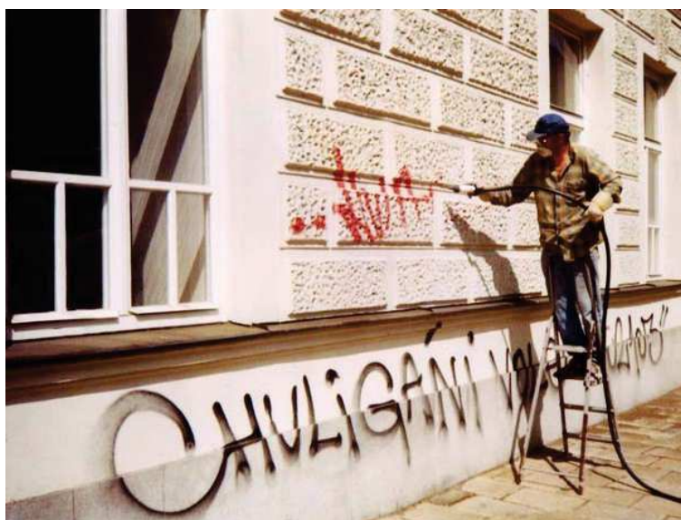
Obrázek 6: Odstraňování graffiti tryskáním suchým ledem [33]
