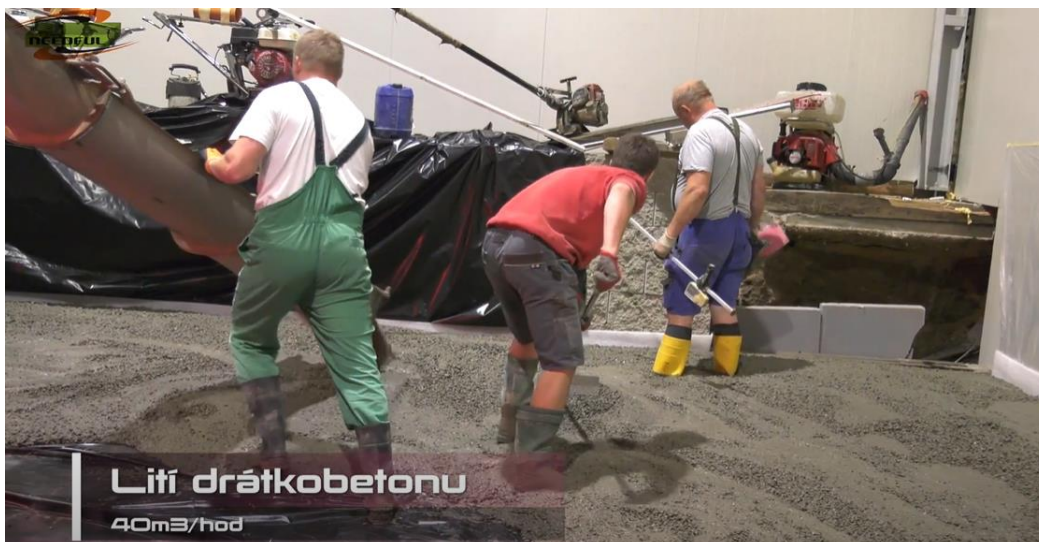
Obr. 11.17 Průběh betonáže [64]
