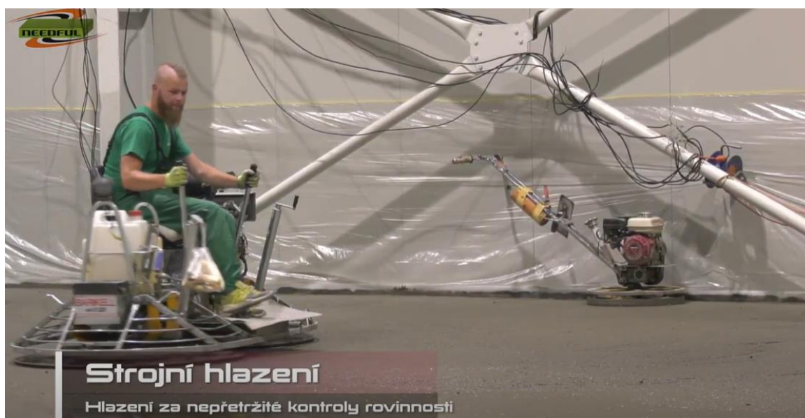
Obr. 11.18 Hlazení betonu [64]
