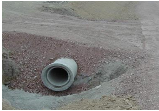
Obr. 5.2 Přejezd na stavenišťe [12]
