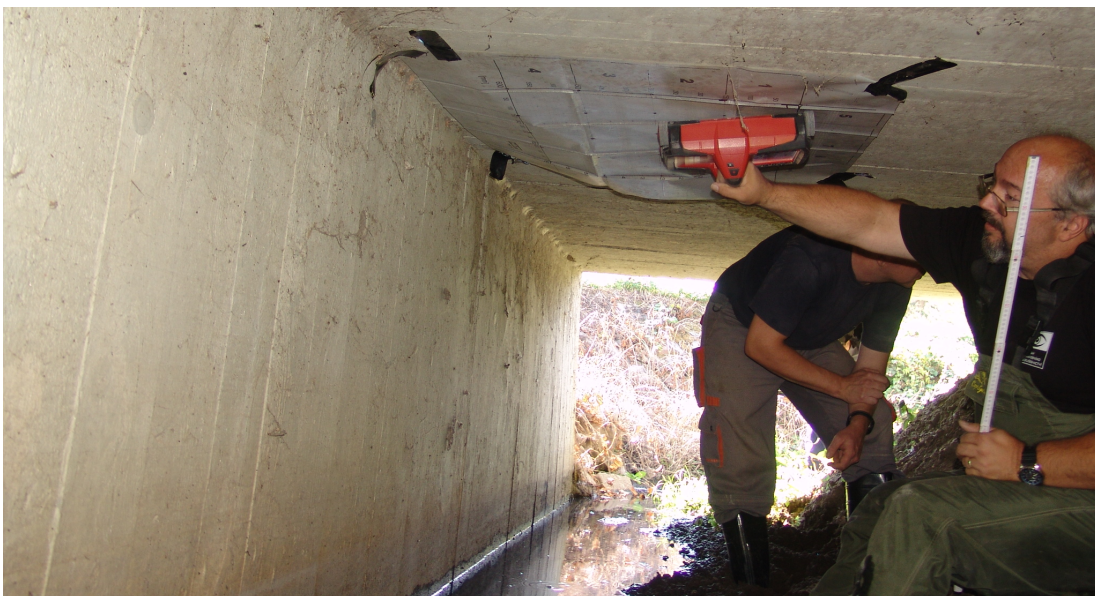
Obr. 40: Provádění georadarového skenu v místě sondy R2 [F]
