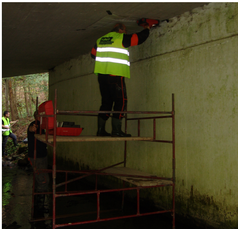
Obr. 13: Provádění georadarového skenu v místě sondy R2 [F]
