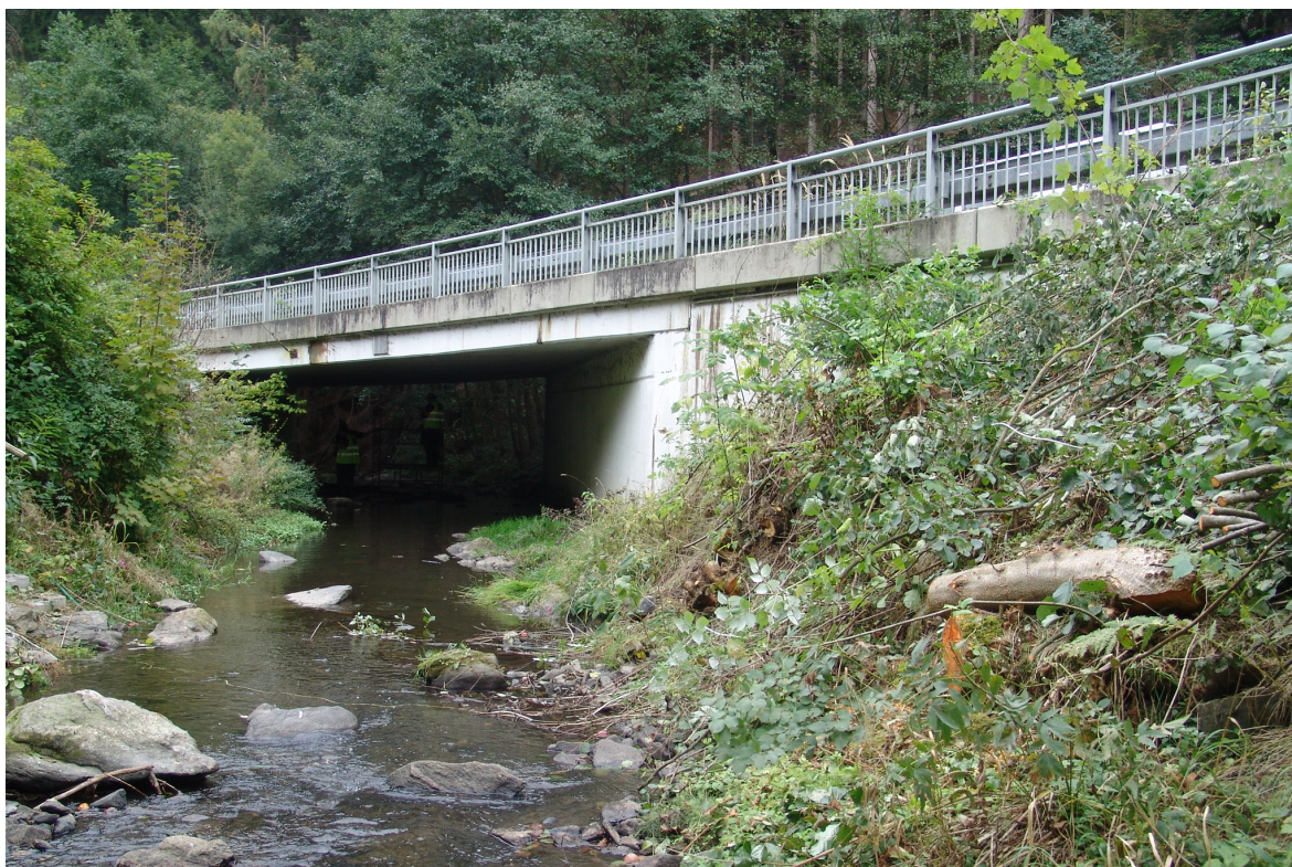
Obr. 7: Pohled na návodní stranu mostu [F]
