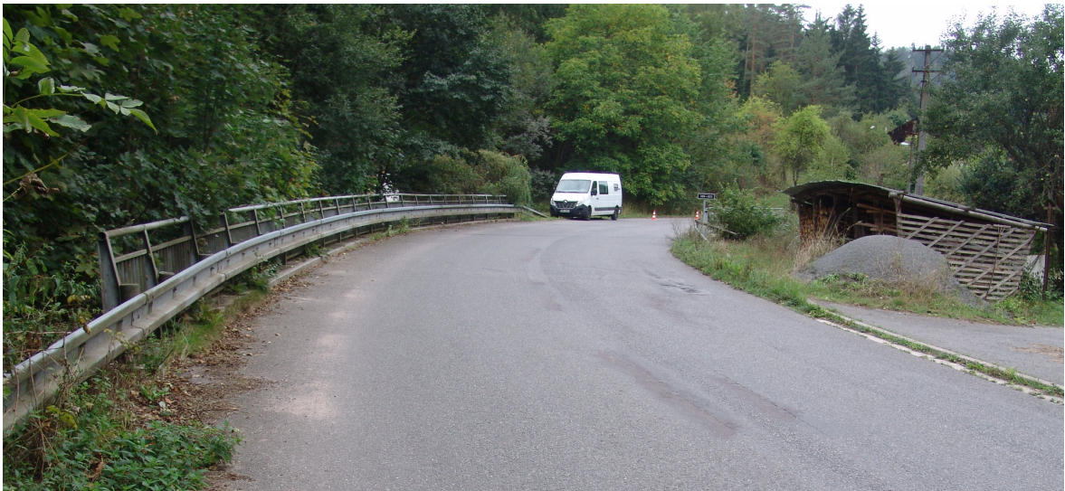
Obr. 6: Pohled na most v protisměru staničení [F]
