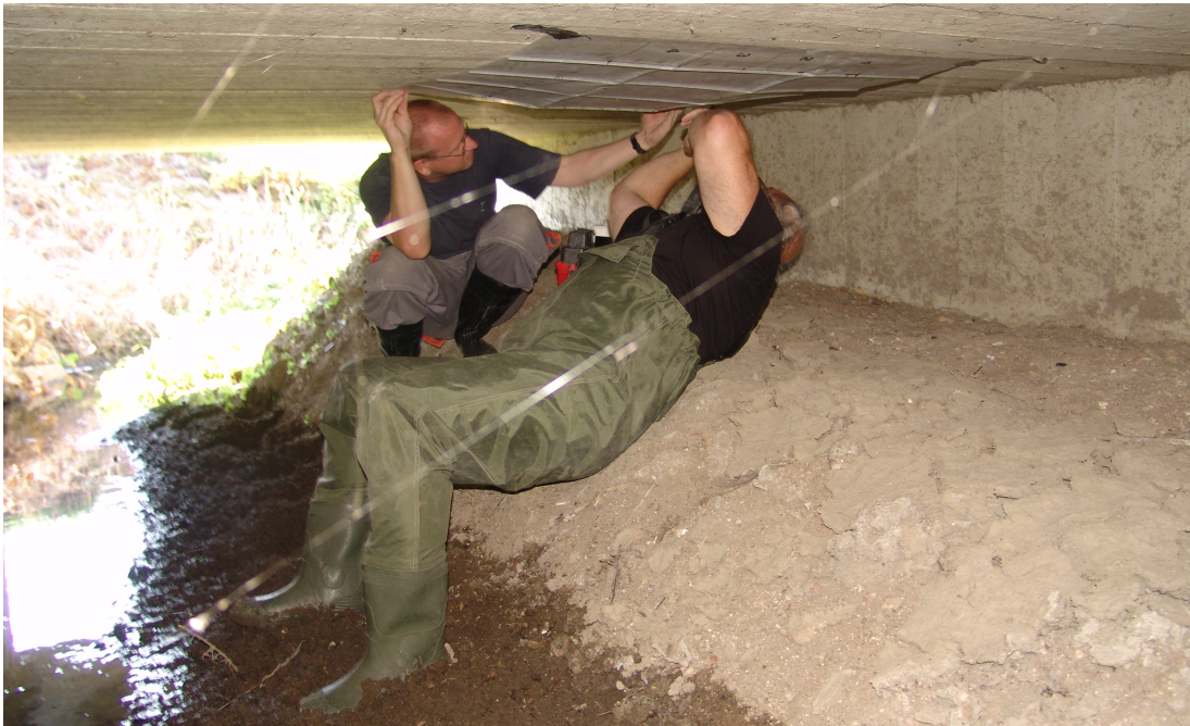
Obr. 39: Provádění georadarového skenu v místě sondy R1 [F]
