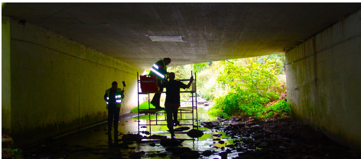
Obr. 12: Provádění georadarového skenu v místě sondy R1 [F]
