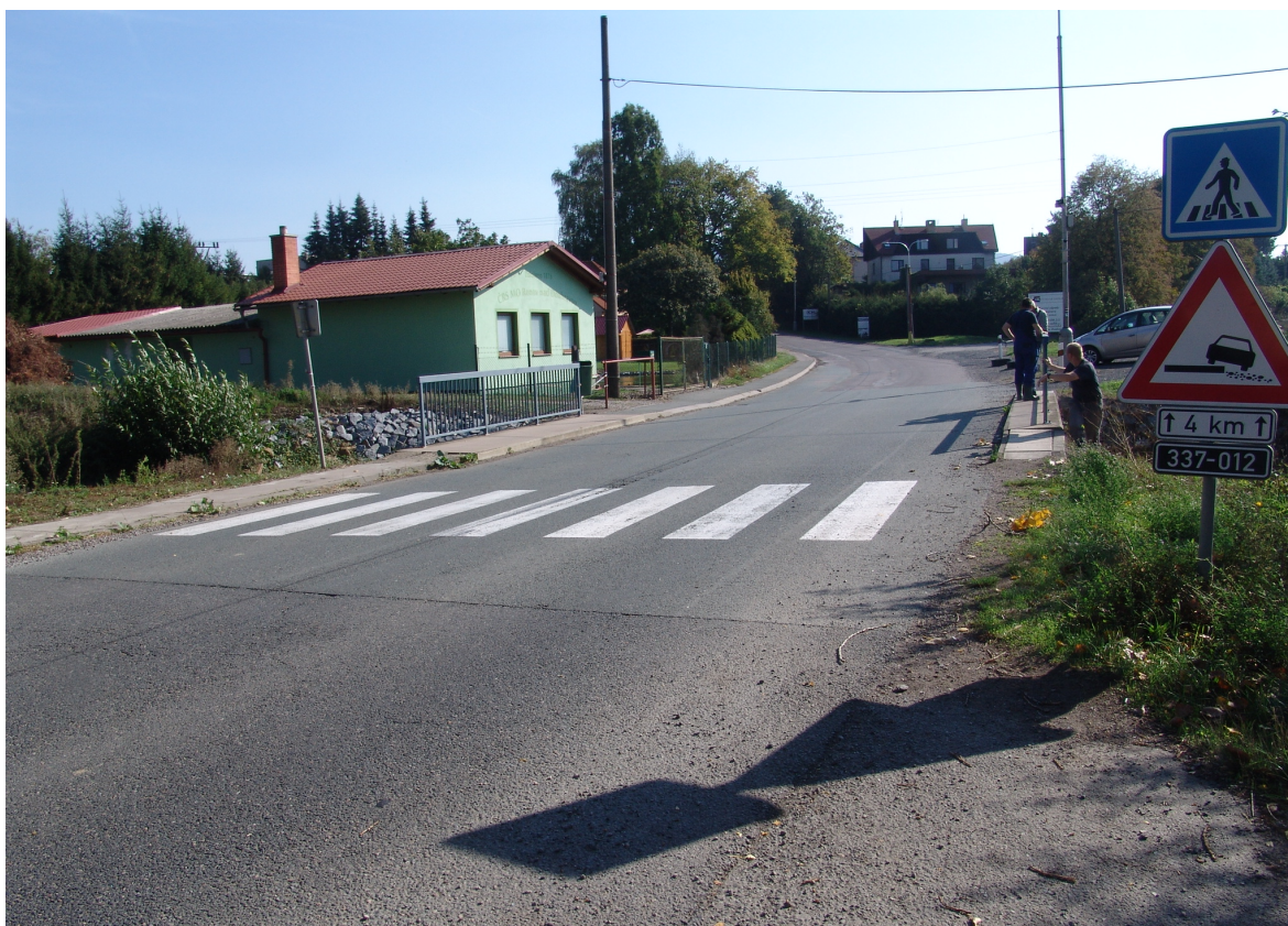
Obr. 37: Pohled na most v protisměru staničení [F]
