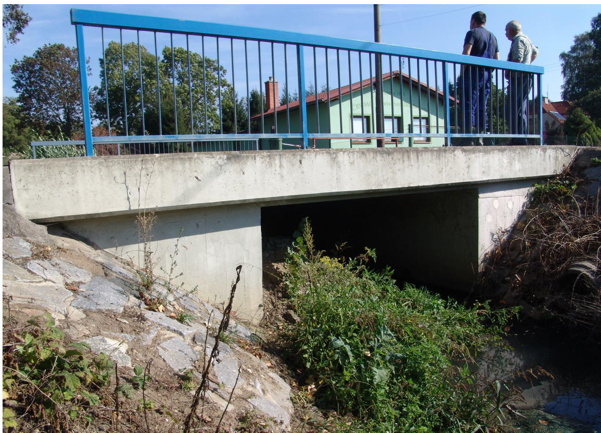
Obr. 38: Pohled na návodní stranu mostu [F]
