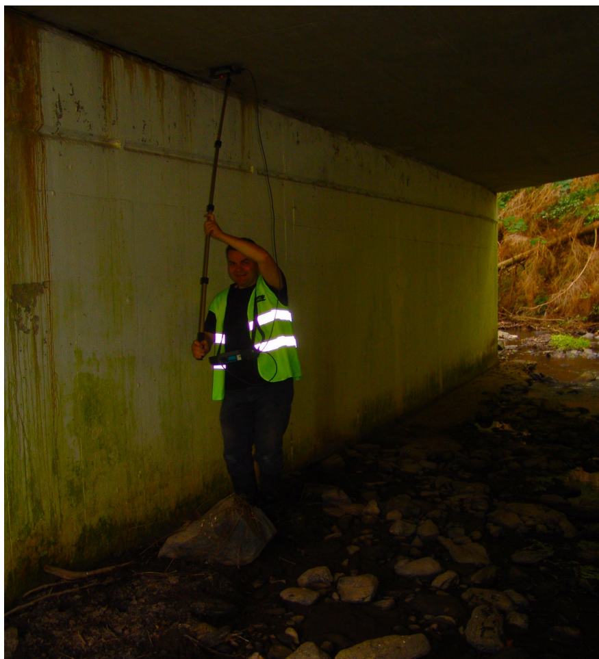
Obr. 15: Provádění liniového skenu elektromagnetickým indikátorem [F]
