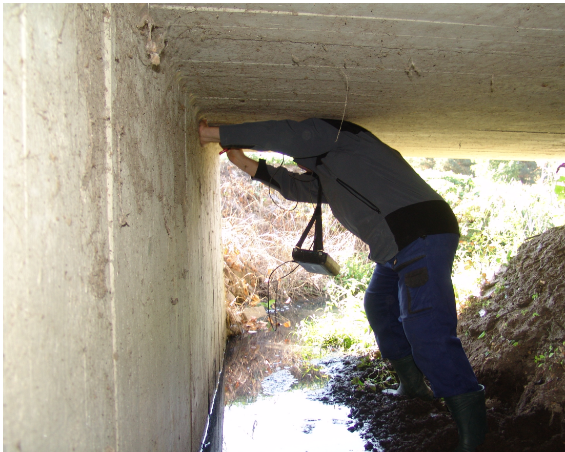
Obr. 42: Provádění liniového skenu elektromagnetickým indikátorem [F]
