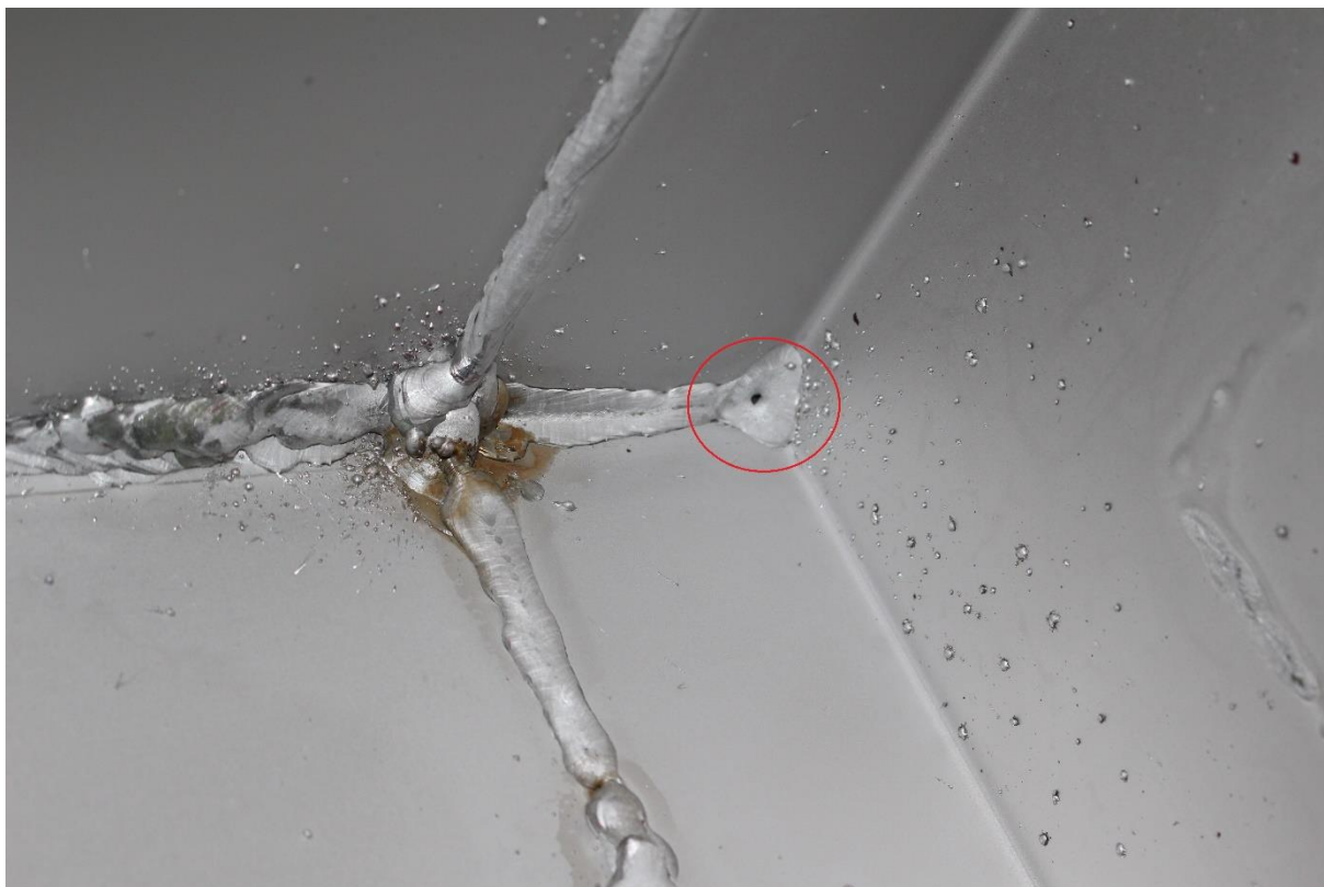
Obr. 9 Příklad kráterové trhliny
