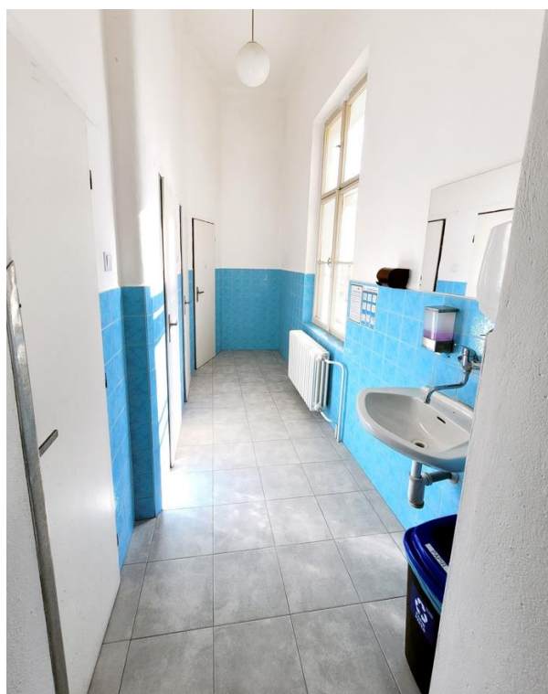
Obrázek 7 Toalety zámku Kuřim po rekonstrukci (zdroj: skoladivizna.cz)
