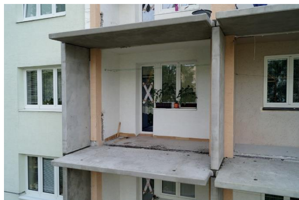
Obrázek 11 Proces výstavby lodžii 2. (interní zdroje)
