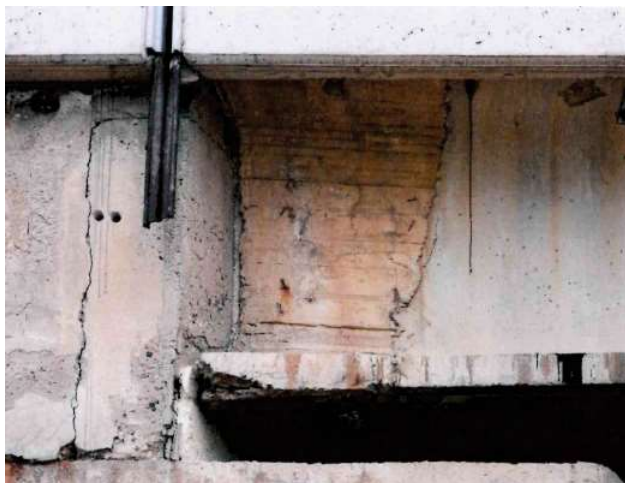
Obrázek 19: Atypická dobetonávka kotevní oblasti nosníku IS-73 [2]
