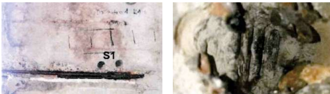
Obrázek 17: Detaily vrtaných sond pro ověření injektáže předpínacích kabelů [2]
