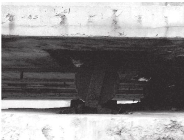
Obrázek 20: Vykloněné válcové ocelové ložisko [2]
