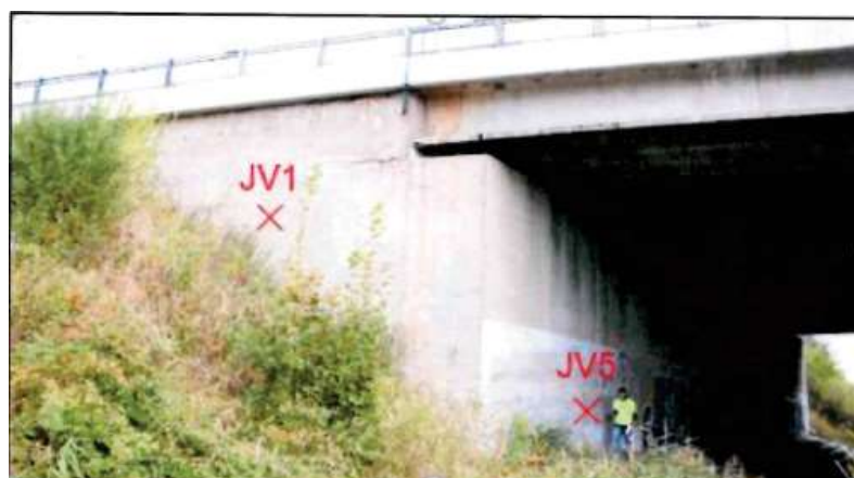
Obrázek 13: Pohled na opěru O1 na místa odběrů [2]
