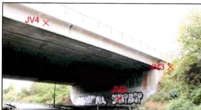
Obrázek 14: Pohled na opěru O2 a na místa odběrů [2]
