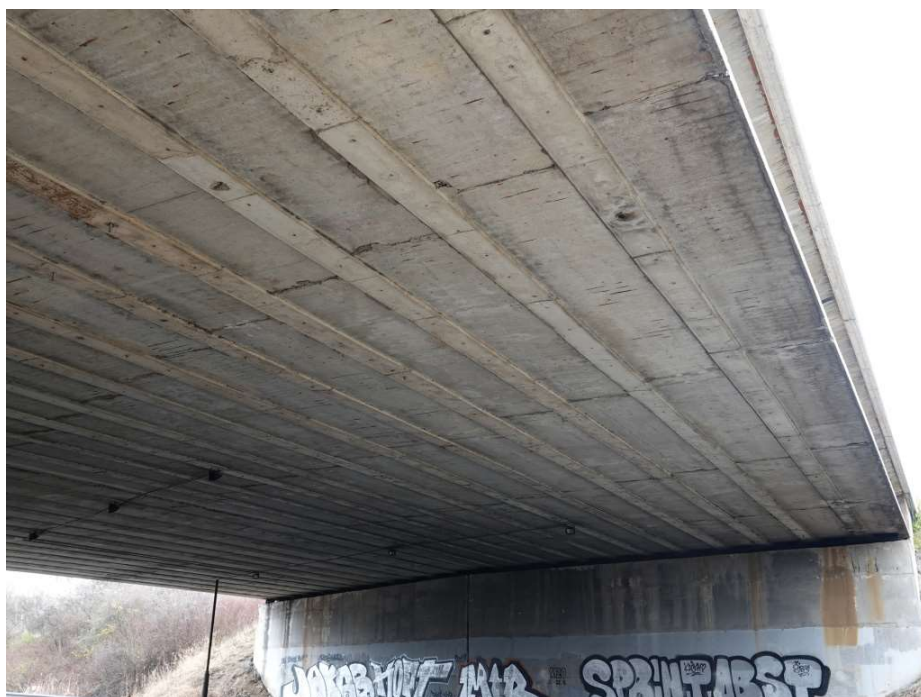
Obrázek 6: Pohled na prefabrikované nosníky IS-73
