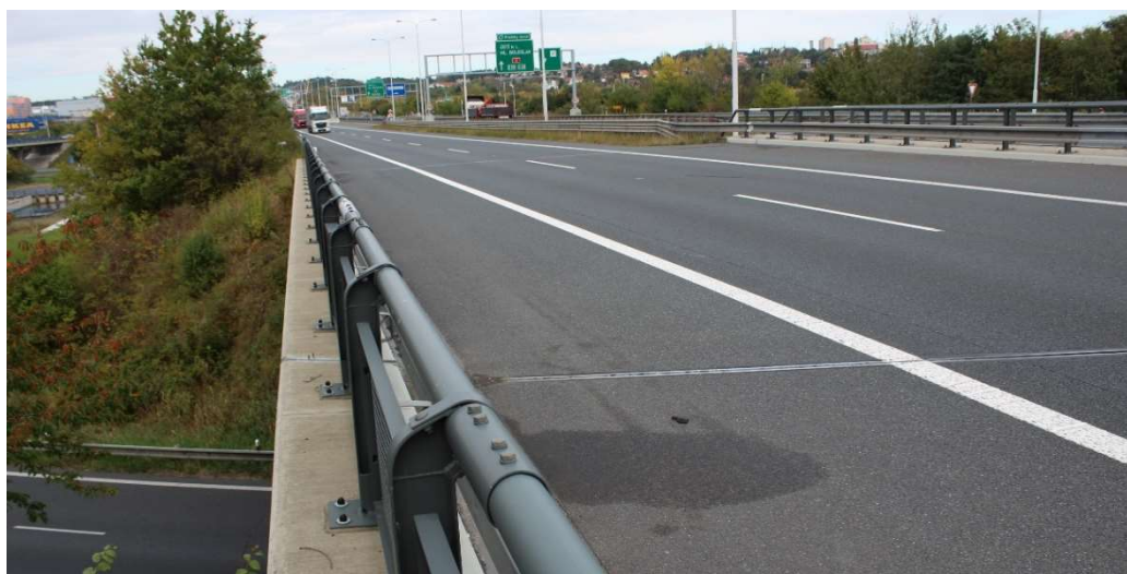
Obrázek 3: Pohled na most v protisměru staničení
