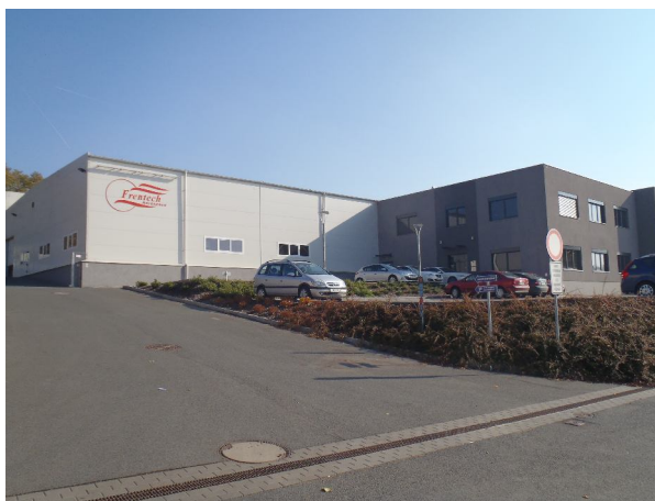
Obr. 2.1 Nový objekt společnosti Frentech Aerospace s.r.o.
