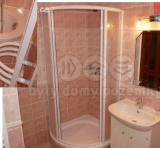
Obrázek 6-28 Byt . 07 - vybavení po rekonstrukci 3
