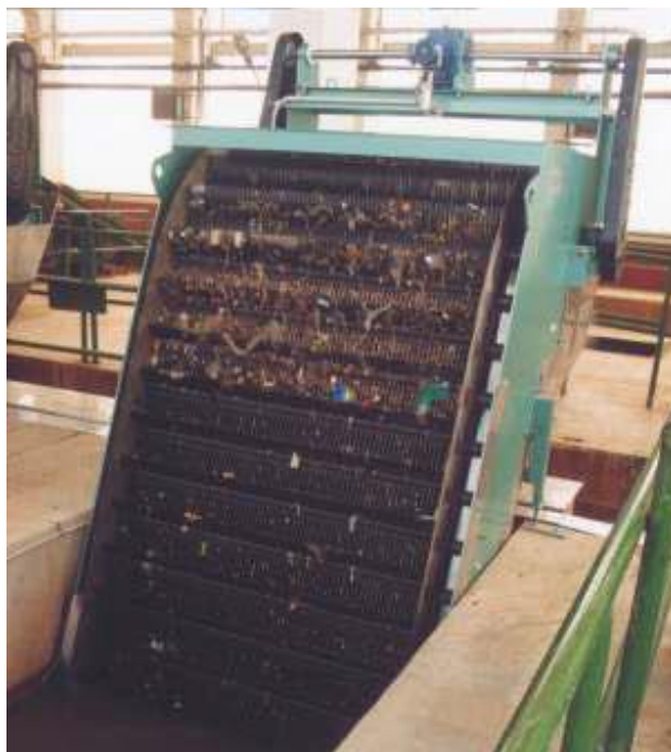
Obrázek 10 Samočistící česle od firmy Fontanar na ČOV v Brně – Modřicích [11]
