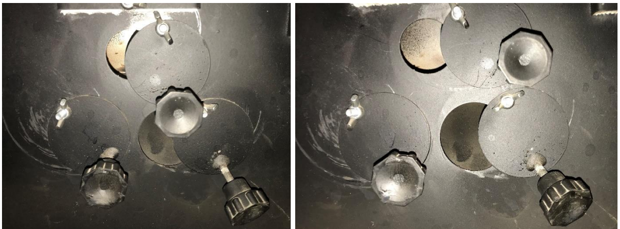
Obrázek 7 - Nastavení kotle, při spalování dřeva, je zde vidět změna nastavení sekundárního vzduchu (vrchní klapka)
