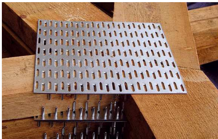
Obr. 9.2 Styčnicková deska s prolisovanými trny spojující 4 pruty, zdroj [16]
