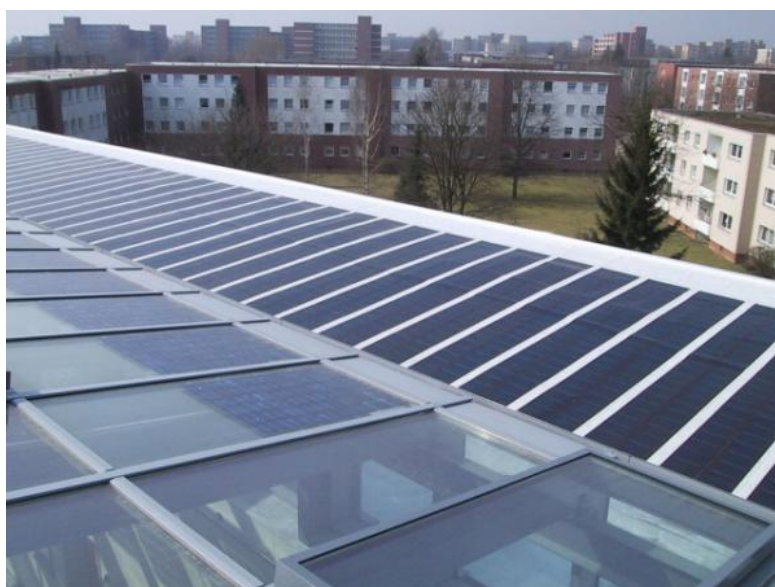
Obr.1. Příklad využití fotovoltaických panelů - EVALON-Solar Fotovoltaický systém pro rovné střechy [4]
