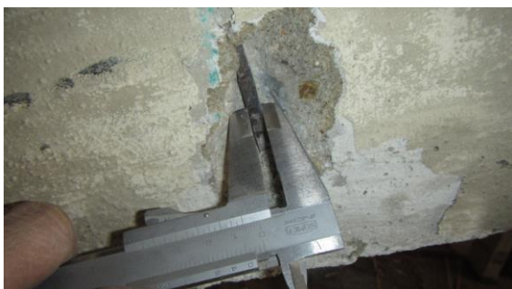
Obrázek 242 Foto měření průměru třmínku v sondě Ž - 1 na žebro mezi sloupy C7 - B7
