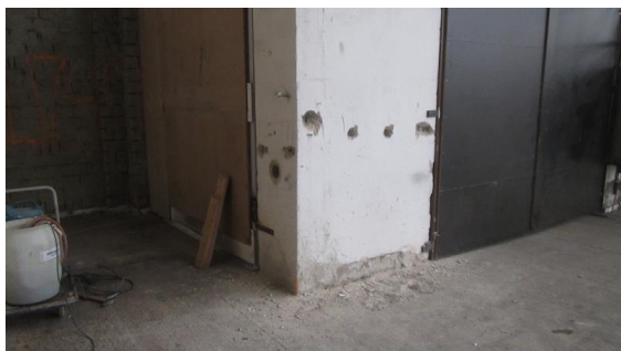
Obrázek 140 Pohled na sloup M-7 s provedenou sekanou sondou M-7.1
