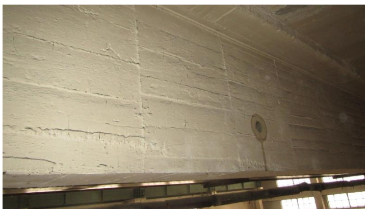
Obrázek 23 Vodorovný železobetonový průvlak
