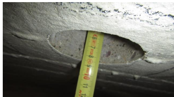
Obrázek 99 Hloubka odebraného jádrového vývrtnu V17.1
