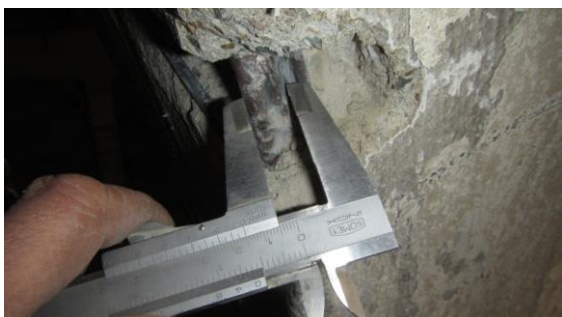
Obrázek 257 Foto měření průměru hlavní výztuže v sondě V - 1
