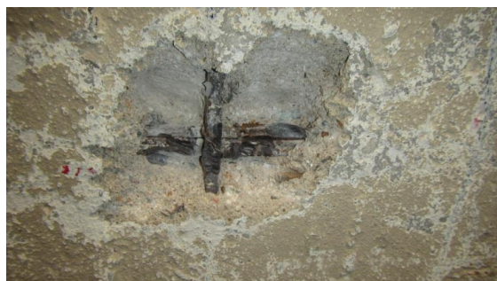
Obrázek 189 Foto sekané sondy D - 2 na skořepině v úseku G, F – 7,5
