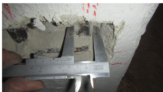
Obrázek 145 Foto měření průměru hlavní nosné výztuže v sondě M-7.1
