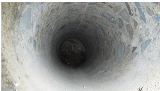
Obrázek 28 Pohled do odebraného jádrového vývrtu ze sloupu D-7
