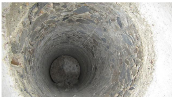
Obrázek 32 Pohled do odebraného jádrového vývrtu ze sloupu G - 9
