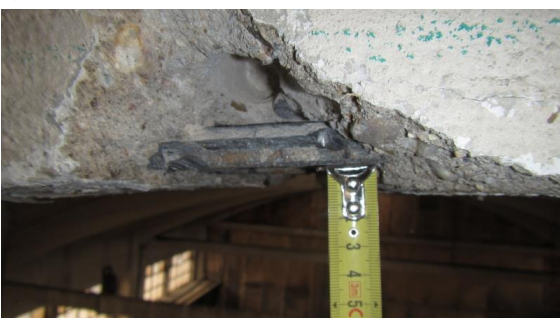
Obrázek 271 Zachycení měření krycí vrstvy hlavní výztuže od spodního líce žebra
