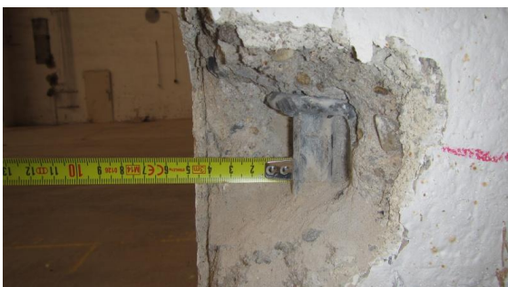
Obrázek 112 Foto tloušťky krycí vrstvy na delší straně sloupu D-7
