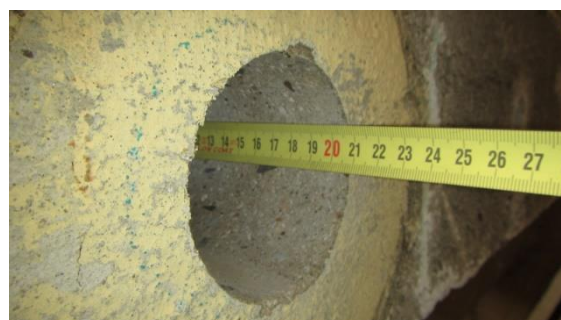
Obrázek 85 Hloubka odebraného jádrového vývrtnu V11.1
