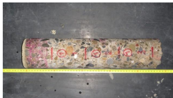
Obrázek 29 Zachycení zkoušky karbonatace vzorku z vývrtu V1 fenofltaleinem
