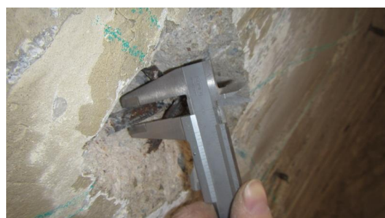
Obrázek 183 Foto měření průměru šikmé výztužné vložky v sondě D - 1
