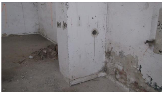
Obrázek 38 Pohled na sloup P - 8 s odebraným jádrovým vývrtem
