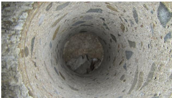
Obrázek 76 Pohled do odebraného jádrového vývrtnu V9.1
