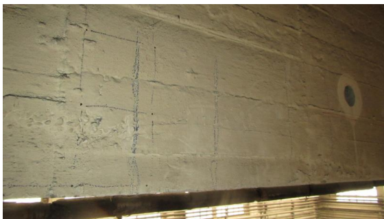
Obrázek 222 Pohled na průvlak v úseku mezi sloupy M7 - M9 s provedenou sekanou sondou P - 3
