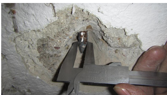
Obrázek 162 Pohled na měření průměru hlavní nosné výztuže v sondě P-8.1
