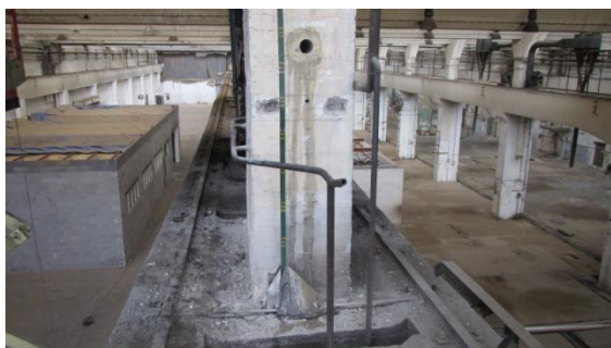
Obrázek 42 Pohled na sloup M - 7 s odebraným jádrovým vývrtem
