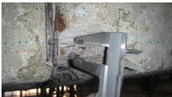
Obrázek 220 Foto měření průměru hlavní výztuže v sondě P - 2
