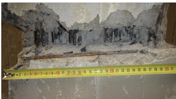
Obrázek 238 Foto měření šířky žebra přibližně v polovině rozpětí mezi sloupy C7 - B7
