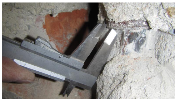
Obrázek 123 Pohled na měření průměru třmínku
