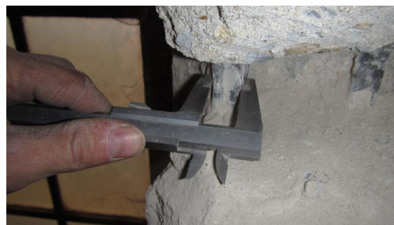
Obrázek 169 Foto měření průměru hlavní nosné výztuže v sondě P-8.2
