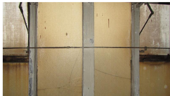
Obrázek 276 Bližší foto zkoumaného okenního sloupku (jedná se o prostřední sloupek)
