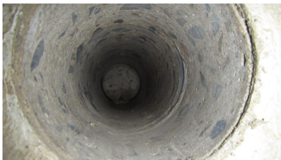
Obrázek 48 Pohled do odebraného jádrového vývrtu ze sloupu P - 8
