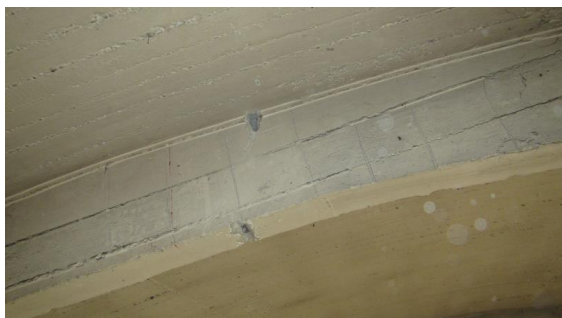
Obrázek 283 Pohled na obloukové žebro v úseku mezi sloupy s označením M10 – P10
