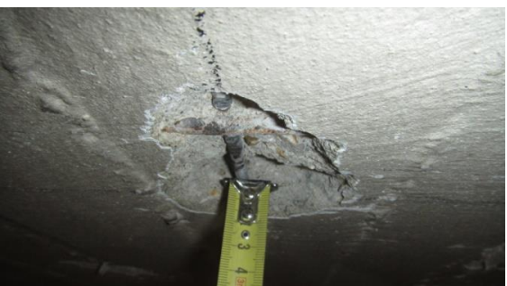
Obrázek 190 Měření krycí vrstvy vodorovné výztuže v sondě D - 2
