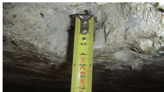
Obrázek 195 Foto měření krycí vrstvy hladké výztuže v sondě D - 3
