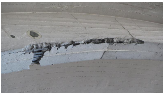
Obrázek 243 Pohled na obloukové žebro v úseku mezi sloupy H7 - G7
