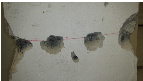
Obrázek 126 Foto sekané sondy na kratší straně sloupu G-9
