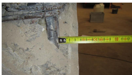
Obrázek 129 Foto tloušťky krycí vrstvy na protější kratší straně sloupu G-9
