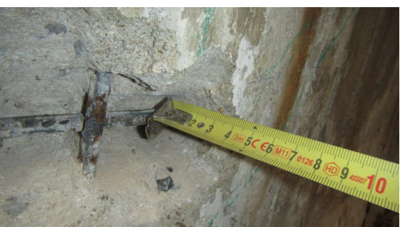
Obrázek 182 Měření krycí vrstvy vodorovné výztuže v sondě D - 1
