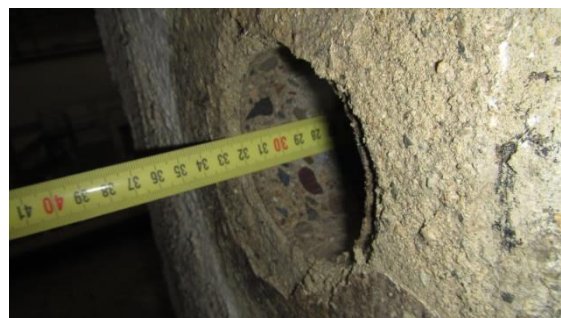
Obrázek 55 Foto-dokumentace hloubky jádrového vývrtu ze sloupu H - 7
