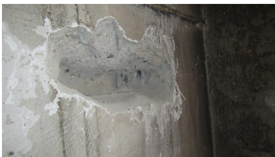
Obrázek 166 Foto sekané sondy na delší straně sloupu P-8
