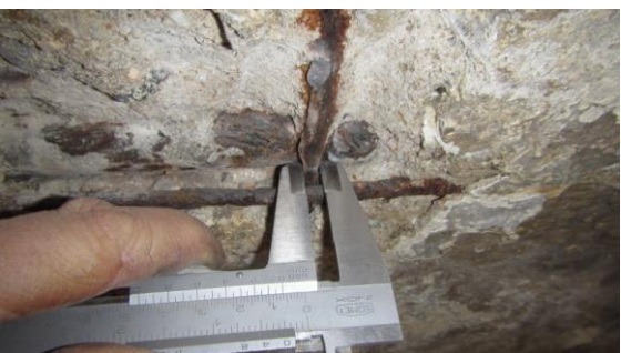
Obrázek 196 Měření průměru svislé hladké výztuže v sondě D - 3
