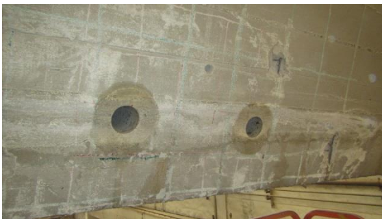
Obrázek 74 Místo odběru jádrových vývrtnů ze železobetonového průvlatku na ose E
