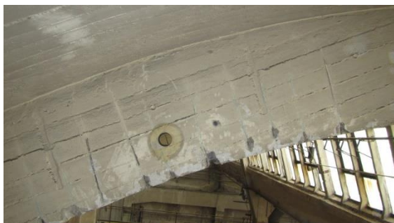
Obrázek 80 Pohled na místo odběru jádrového vývrtu ze železobetonového oblouku na ose 7 v úseku mezi sloupy B - 7 a C - 7
