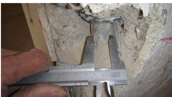
Obrázek 114 Pohled na měření průměru hlavní nosné výztuže
