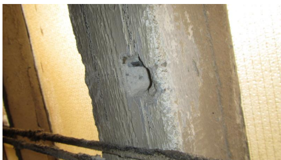
Obrázek 277 Zachycení provedené sekané sondy za účelem zjištění skutečného vyztužení sloupku
