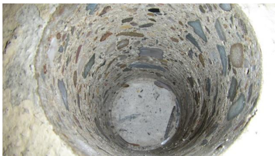
Obrázek 106 Pohled do odebraného jádrového vývrtu z železobetonového šikmého sloupku nad sloupem K - 7
