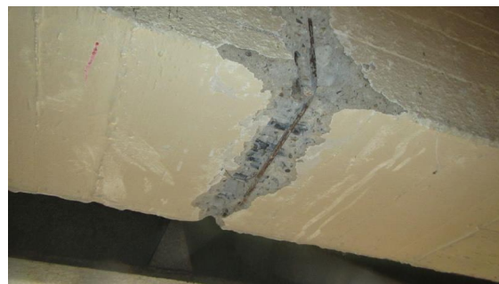
Obrázek 223 Zachycení sekané sondy P - 3 na průvlaku v úseku mezi sloupy M7 - M9
