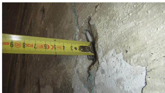
Obrázek 239 Měření krycí vrstvy třmínků na boční stěně obloukového žebra střešní konstrukce
