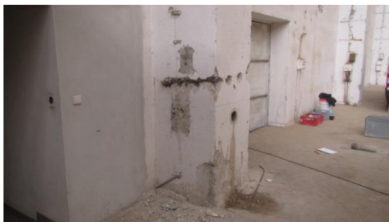
Obrázek 30 Pohled na sloup G - 9 s odebraným jádrovým vývrtem
