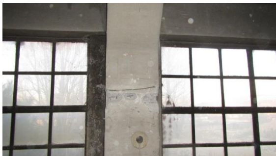
Obrázek 46 Pohled na sloup P - 8 s odebraným jádrovým vývrtem
