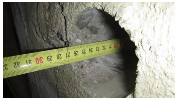
Obrázek 51 Foto-dokumentace hloubky jádrového vývrtu ze sloupu F - 9
