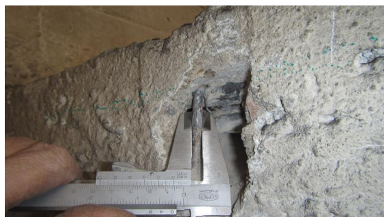
Obrázek 274 Foto měření průměru třmínků průvlaku v sondě Ž - 3
