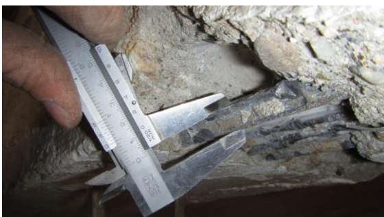
Obrázek 273 Foto měření průměru hlavní výztuže v sondě Ž - 3
