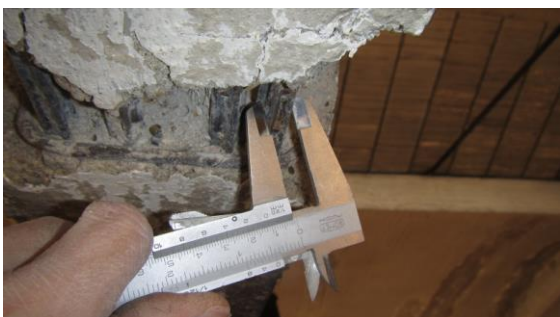
Obrázek 297 Foto měření průměru jedné z hlavních výztuží při spodním líci
