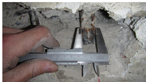
Obrázek 153 Foto měření průměru hlavní nosné výztuže v sondě M-7.2
