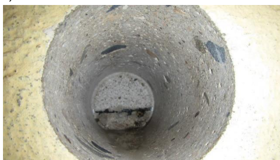
Obrázek 88 Pohled do odebraného jádrového vývrtnu V11.2
