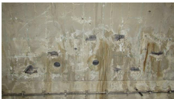
Obrázek 68 Místo odběru jádrových vývrtů ze skořepiny
