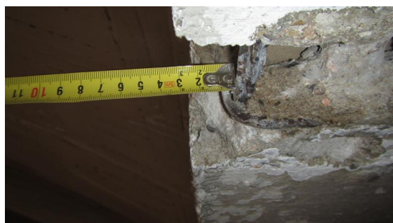
Obrázek 233 Foto měření krycí vrstvy od bočního líce jedné z hlavních výztuží průvlaku
