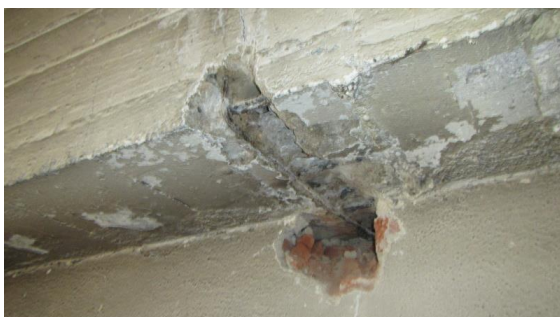
Obrázek 230 Bližší foto sekané sondy průvlaku
