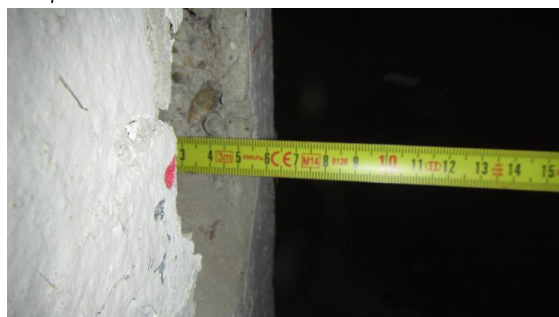
Obrázek 159 Foto měření krycí vrstvy na delší straně sloupu P-8 v sondě P-8.1
