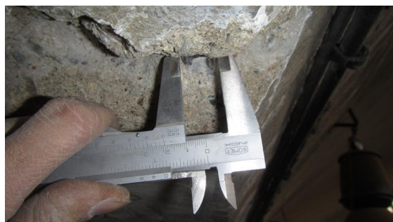
Obrázek 221 Foto měření průměru hlavní výztuže průvlaku v sondě P - 2
