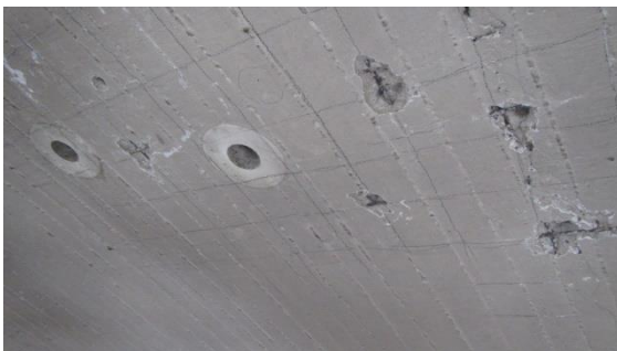
Obrázek 98 Místo odběru jádrových vývrtnů ze skořepiny
