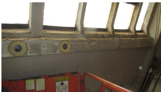
Obrázek 84 Místo odběru jádrových vývrtnů ze železobetonového římsy průvlaku na ose F
