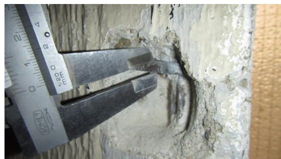
Obrázek 282 Foto měření průměru třmínků průvlaku v sondě V - 3
