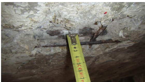
Obrázek 194 Foto měření krycí vrstvy výztuže ROXOR s průměrem 25 mm v sondě D - 3
