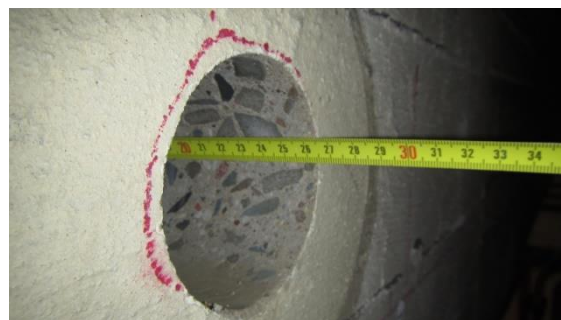
Obrázek 65 Hloubka odebraného jádrového vývrtu z železobetonového průvlaku na ose M v úseku mezi sloupy M - 7 a M - 9
