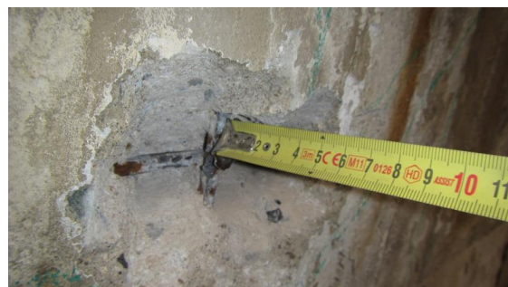
Obrázek 181 Foto měření krycí vrstvy svislé výztuže v sondě D - 1
