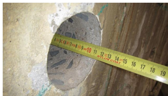
Obrázek 69 Hloubka odebraného jádrového vývrtnu V8.1
