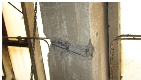
Obrázek 252 Zachycení sekané sondy V - 1 na vzpěře shedové konstrukce nad sloupem D7
