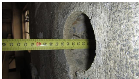
Obrázek 59 Foto-dokumentace hloubky jádrového vývrtu ze sloupce H - 7
