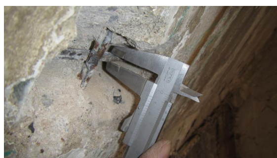
Obrázek 185 Foto měření průměru vodorovné výztuže v sondě D - 1
