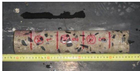
Obrázek 83 Fenolftaleinová zkušební těleska na hloubku karbonatace betonu na jádrovém vývrtu z železobetonového oblouku na ose 7 v úseku mezi sloupy B - 7 a C - 7
