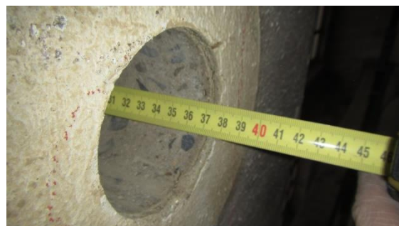
Obrázek 47 Foto-dokumentace hloubky jádrového vývrtu ze sloupu P - 8
