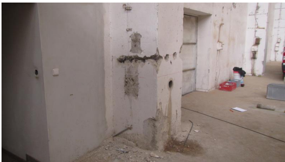
Obrázek 124 Pohled na sloup G-9 s provedenou sekanou sondou
