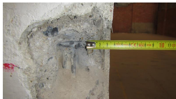
Obrázek 113 Foto tloušťky krycí vrstvy na kratší straně sloupu D-7
