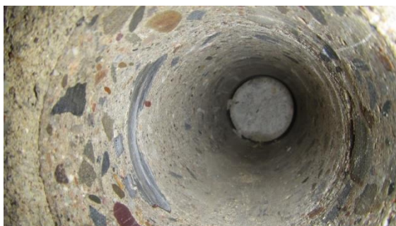
Obrázek 56 Pohled do odebraného jádrového vývrtu ze sloupu H - 7
