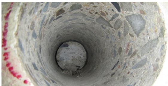
Obrázek 66 Pohled do odebraného jádrového vývrtu z železobetonového průvlaku na ose M v úseku mezi sloupy M - 7 a M - 9
