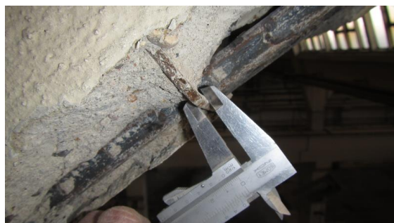
Obrázek 250 Foto měření průměru třmínků průvlaku v sondě Ž - 2
