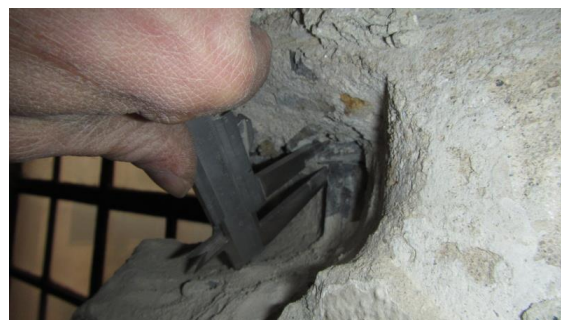
Obrázek 171 Pohled na měření průměru třmínku
