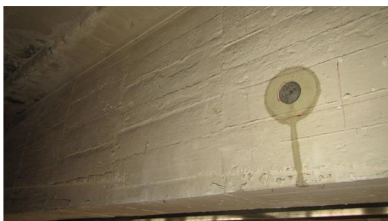
Obrázek 64 Železobetonový průvlak na ose M v úseku mezi sloupy M - 7 a M - 9
