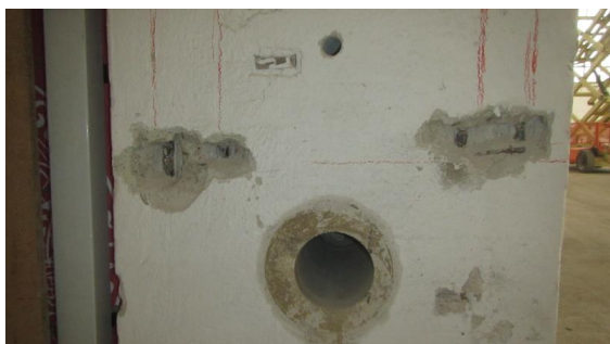
Obrázek 142 Foto sekané sondy na kratší straně sloupu M-7
