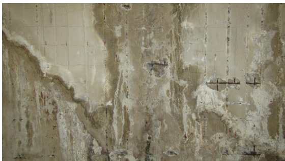
Obrázek 192 Pohled na skořepinu v úseku M, N – 7, 8 s provedenou sekanou sondou D - 3
