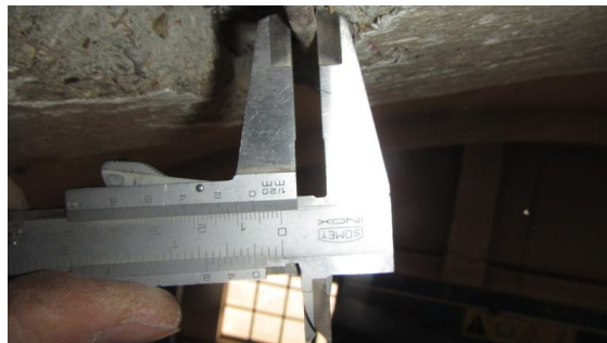
Obrázek 290 Foto měření průměru třmínků průvlaku v sondě Ž - 4
