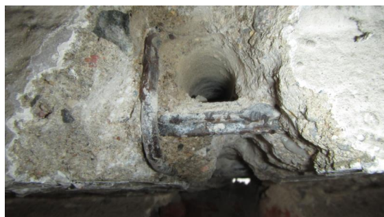
Obrázek 231 Bližší foto sekané sondy spodního líce průvlaku mezi sloupy F7 – F5
