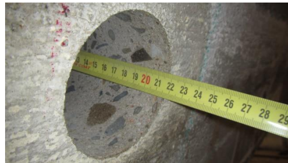
Obrázek 77 Hloubka odebraného jádrového vývrtnu V9.2
