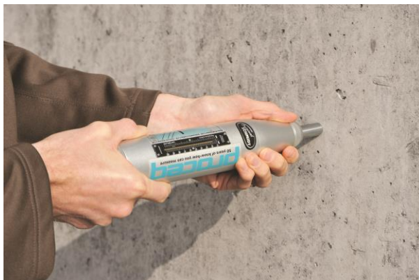
Obrázek 6 Provádění zkoušky tvrdoměrem Schmidt [11]
