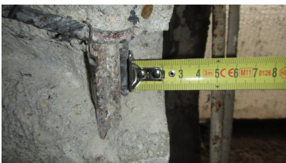
Obrázek 263 Zachycení měření krycí vrstvy od bočního líce vzpěry
