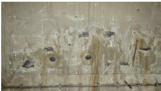
Obrázek 178 Pohled na skořepinu v úseku C,D –
