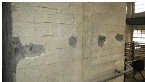
Obrázek 149 Zachycení sekané sondy M-7.2 na sloupu M-7 nad jeřábovou dráhou
