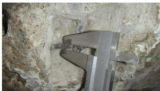
Obrázek 199 Foto měření průměru hladké výztuže v sondě D - 3
