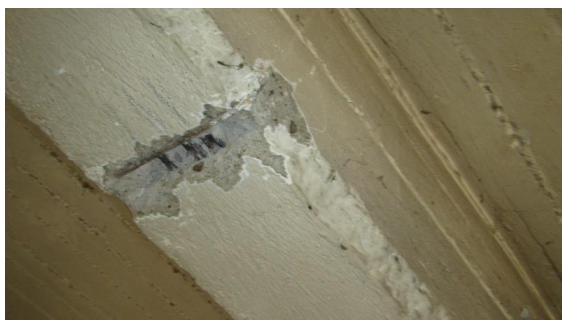
Obrázek 285 Zachycení sekané sondy na spodním líci obloukového žebra za účelem zjištění skutečného vyztužení
