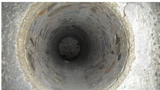
Obrázek 60 Pohled do odebraného jádrového vývrtu ze sloupce H - 7
