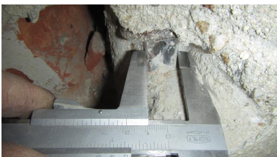
Obrázek 138 Pohled na měření průměru hlavní nosné výztuže
