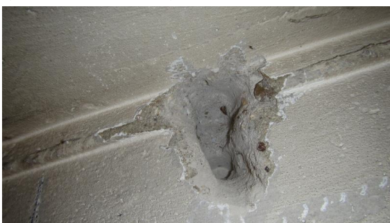
Obrázek 287 Detailní foto sekané sondy v horní části žebra zasahující i do skořepinové desky (výztuž nebyla nalezena)
