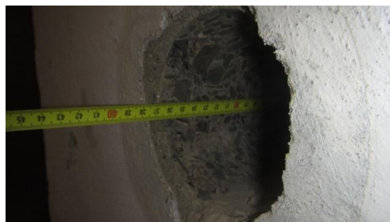
Obrázek 31 Foto-dokumentace hloubky jádrového vývrtu ze sloupu G - 9
