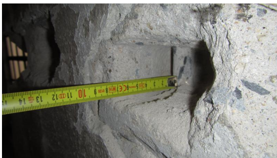
Obrázek 168 Foto tloušťky krycí vrstvy na kratší straně sloupu P-8 v sondě P-8.2
