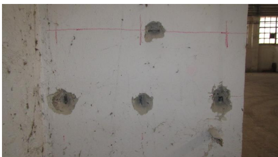
Obrázek 158 Foto sekané sondy na delší straně sloupu P-8
