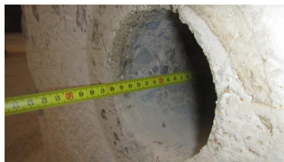
Obrázek 27 Foto-dokumentace hloubky jádrového vývrtu ze sloupu D-7
