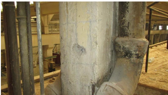
Obrázek 116 Pohled na sloup D-7 s provedenou sekanou sondou nad jeřábovou dráhou
