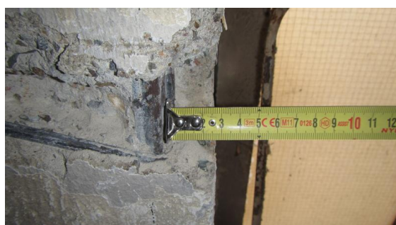
Obrázek 256 Foto měření krycí vrstvy od bočního líce jedné z hlavních výztuží vzpěry
