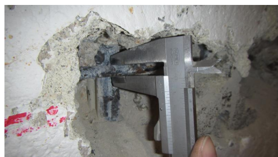
Obrázek 115 Pohled na měření průměru třmínku
