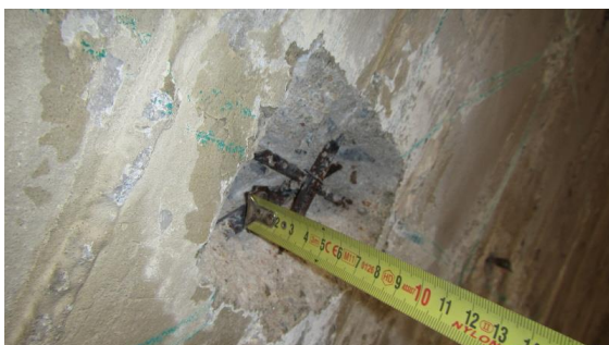
Obrázek 180 Foto měření krycí vrstvy šikmé výztužné vložky v sondě D - 1
