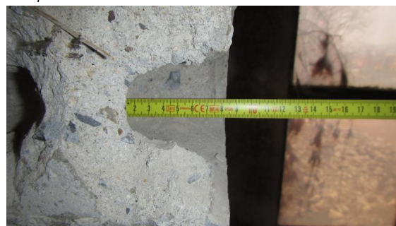
Obrázek 167 Foto měření krycí vrstvy na delší straně sloupu P-8 v sondě P-8.2
