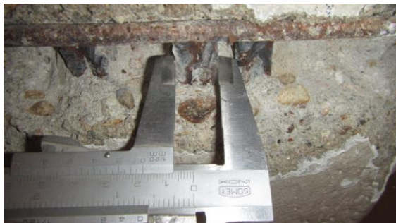
Obrázek 289 Foto měření průměru jedné z hlavních výztuží při spodním líci
