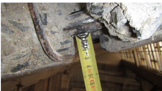
Obrázek 240 Foto měření krycí vrstvy od spodního líce jedné z hlavních výztuží žebra
