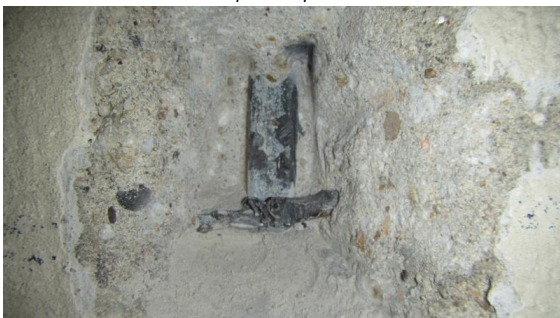
Obrázek 134 Foto sekané sondy na sloupu F-9
