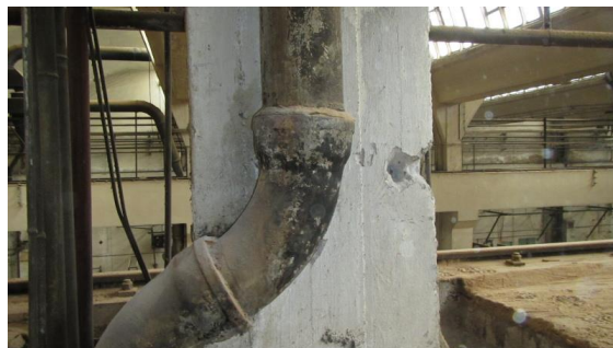
Obrázek 117 Zachycení sekané sondy na delší straně sloupu D-7 nad jeřábovou dráhou
