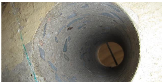
Obrázek 82 Pohled do odebraného jádrového vývrtu z železobetonového oblouku na ose 7 v úseku mezi sloupy B - 7 a C - 7
