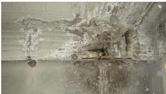
Obrázek 228 Pohled na průvlak v úseku mezi sloupy M9 - M10
