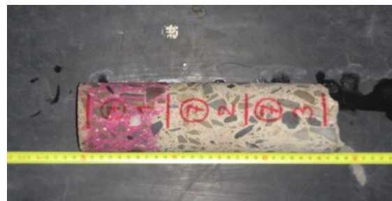
Obrázek 67 Fenolftaleinová zkouška na hloubku karbonatace betonu na jádrovém vývrtu z železobetonového průvlaku na ose M v úseku mezi sloupy M - 7 a M - 9
