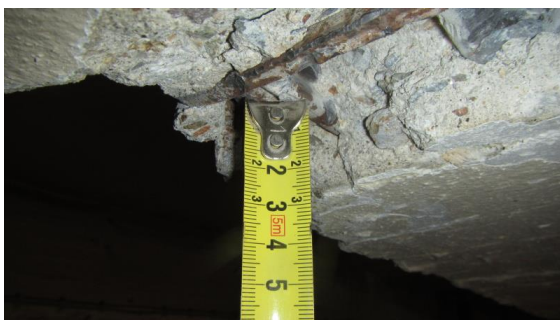
Obrázek 224 Měření krycí vrstvy jedné z hlavních výztuží průvlaku mezi sloupy M7 – M9
