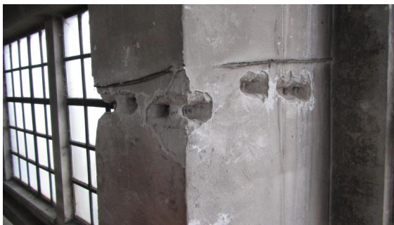
Obrázek 164 Pohled na sloup P-8 s provedenou sekanou sondou P-8.2
