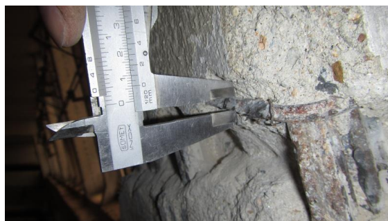
Obrázek 266 Foto měření průměru třmínků průvlaku v sondě V - 2
