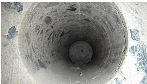
Obrázek 40 Pohled do odebraného jádrového vývrtu ze sloupu P - 8
