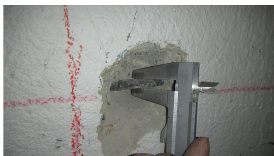
Obrázek 163 Pohled na měření průměru třmínku
