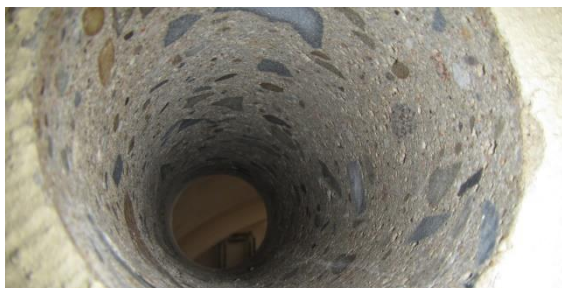
Obrázek 92 Pohled do odebraného jádrového vývrtu z železobetonového oblouku na ose 7 v úseku mezi sloupy G - 7 a H - 7
