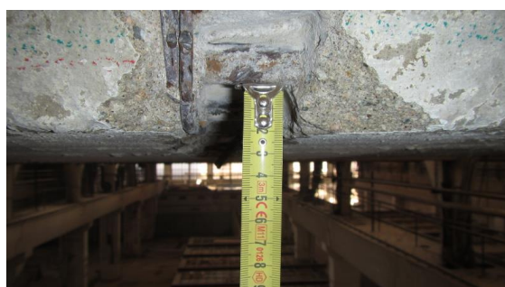
Obrázek 219 Foto měření krycí vrstvy jedné z hlavních výztuží průvlaku
