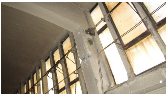
Obrázek 259 Pohled na šikmou vzpěru shedové konstrukce nad sloupem K7
