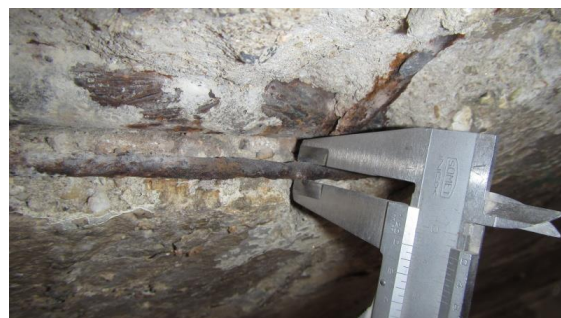
Obrázek 197 Foto měření průměru vodorovné výztuže v sondě D - 3
