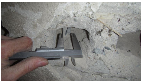
Obrázek 170 Pohled na měření průměru hlavní nosné výztuže v sondě P-8.2
