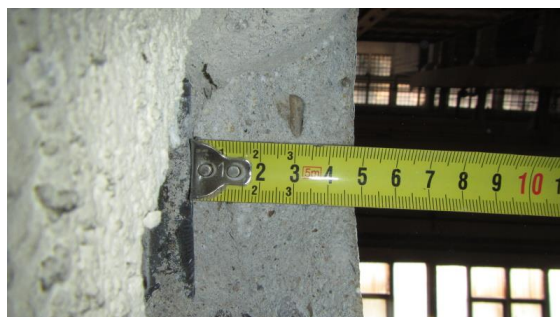
Obrázek 137 Foto tloušťky krycí vrstvy na odkryté straně sloupu F-9
