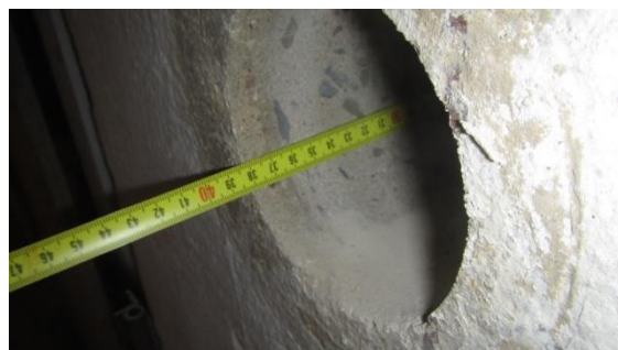
Obrázek 35 Foto-dokumentace hloubky jádrového vývrtu ze sloupu M - 7
