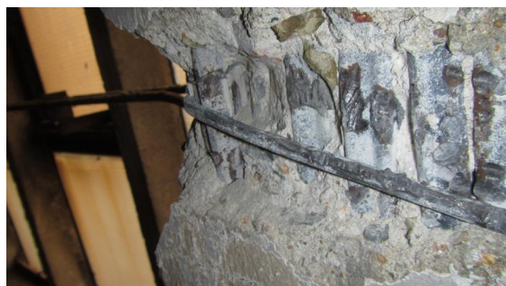
Obrázek 254 Bližší foto sekané sondy spodního líce vzpěry nad sloupem D7
