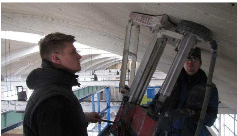
Obrázek 62 Odebírání jádrových vývrtů ze střešních prvků
