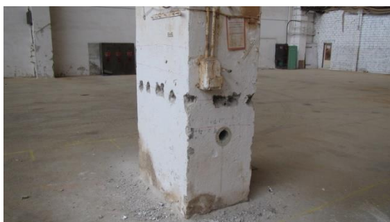
Obrázek 26 Pohled na sloup D-7 s odebraným jádrovým vývrtem
