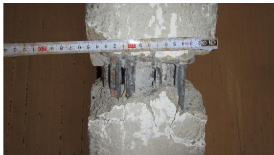
Obrázek 294 Detailní foto odkryté výztuže u spodního povrchu s měřením šířky prvku
