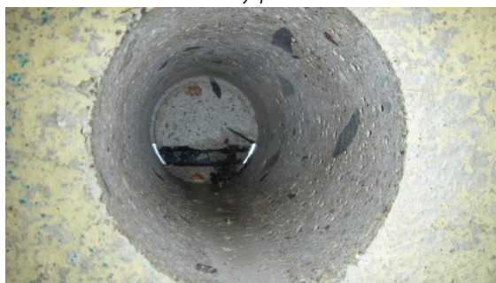
Obrázek 86 Pohled do odebraného jádrového vývrtnu V11.1
