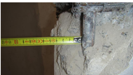
Obrázek 128 Foto tloušťky krycí vrstvy na delší straně sloupu G-9
