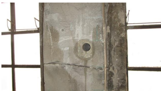
Obrázek 58 Pohled na sloup H - 7 s odebraným jádrovým vývrtem
