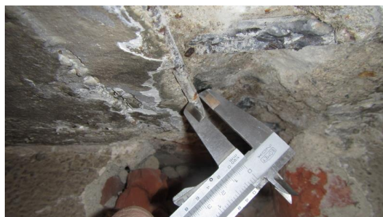
Obrázek 235 Foto měření průměru třmínků průvlaku v sondě P - 4
