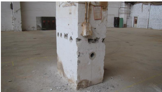
Obrázek 108 Pohled na sloup D-7 s provedenou sekanou sondou
