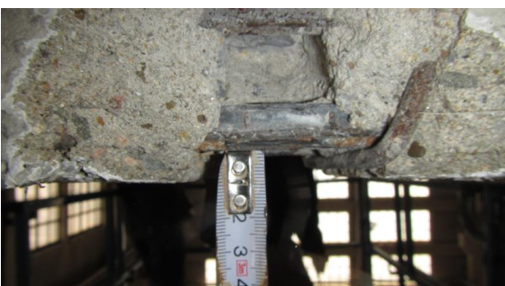
Obrázek 295 Detailní foto měření krycí vrstvy nejspodnější vrstvy výztuže při spodním líci
