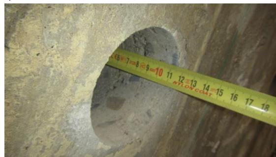
Obrázek 71 Hloubka odebraného jádrového vývrtnu V8.2
