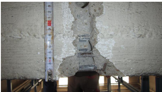
Obrázek 293 Zachycení sekané sondy na bočním líci s měřením jednotlivých vodorovných výztuží
