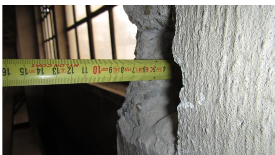
Obrázek 176 Foto tloušťky krycí vrstvy na delší straně sloupu P-8 v sondě P-8.3
