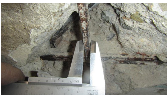
Obrázek 184 Foto měření průměru svislé výztuže v sondě D - 1
