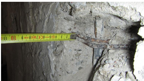
Obrázek 152 Foto tloušťky krycí vrstvy na kratší straně sloupu M-7 v sondě M-7.2
