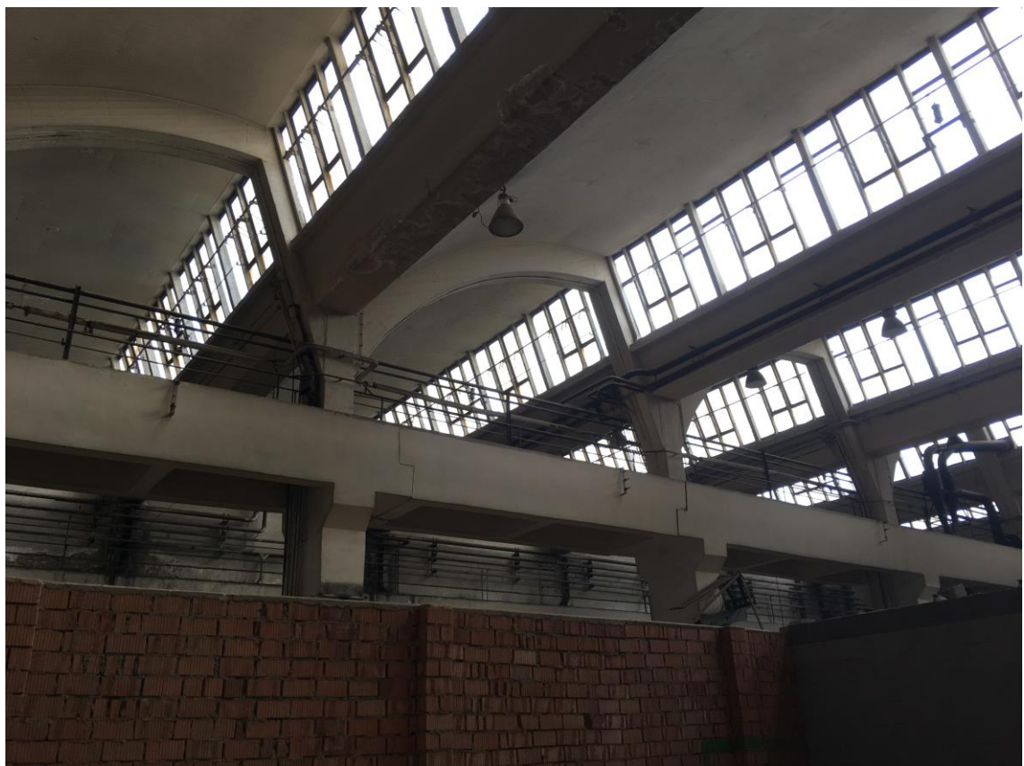
Obrázek 20 Pohled na střešní konstrukční prvky
