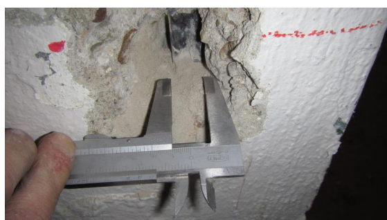
Obrázek 161 Foto měření průměru hlavní nosné výztuže v sondě P-8.1
