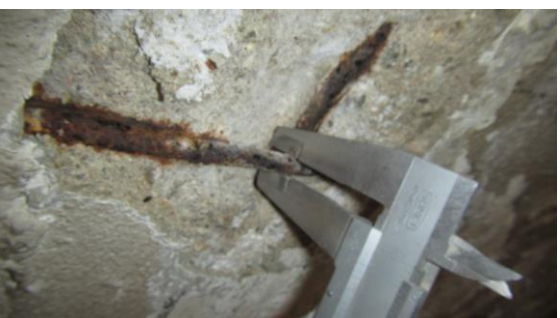
Obrázek 198 Foto měření průměru vodorovné hladké výztuže v sondě D - 3
