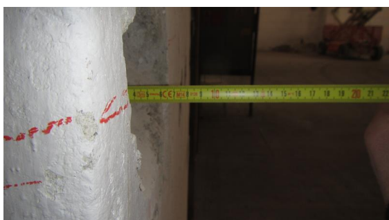
Obrázek 144 Foto tloušťky krycí vrstvy na delší straně sloupu M-7
