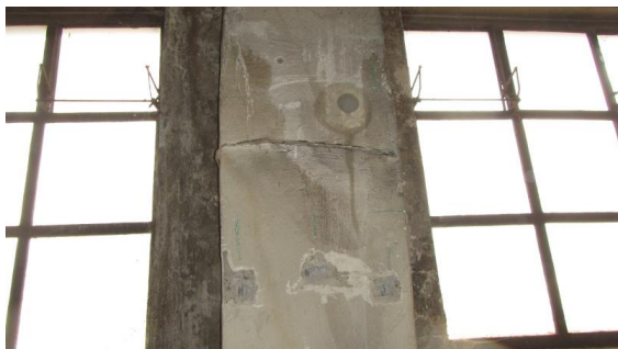
Obrázek 172 Pohled na sloup P-8 s provedenou sekou sonda P-8.3
