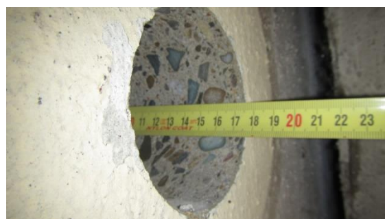
Obrázek 105 Hloubka odebraného jádrového vývrtu z železobetonového šikmého sloupku nad sloupem K - 7
