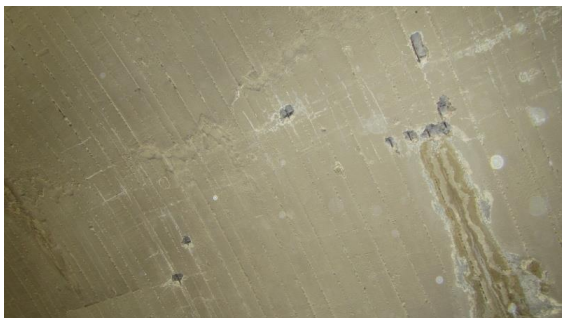
Obrázek 186 Pohled na skořepinu v úseku G, F – 7, 5 s provedenou sekanou sondou D - 2
