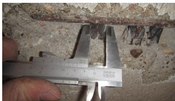
Obrázek 288 Foto měření průměru jedné z hlavních výztuží při spodním líci
