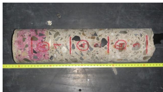
Obrázek 41 Zachycení zkoušky karbonatace vzorku z vývrtu V4 fenofltaleinem
