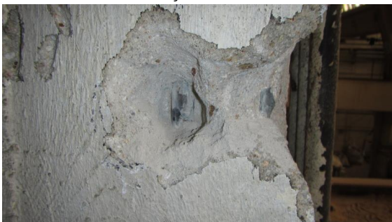
Obrázek 118 Bližší foto sekané sondy sloupu D-7 nad jeřábovou dráhou
