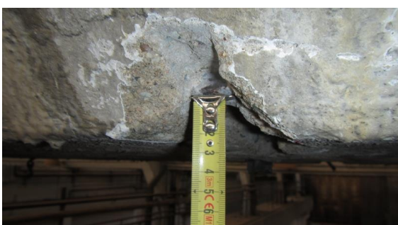
Obrázek 218 Foto měření krycí vrstvy jedné z hlavních výztuží průvlaku
