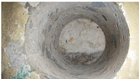
Obrázek 70 Pohled do odebraného jádrového vývrtnu V8.1
