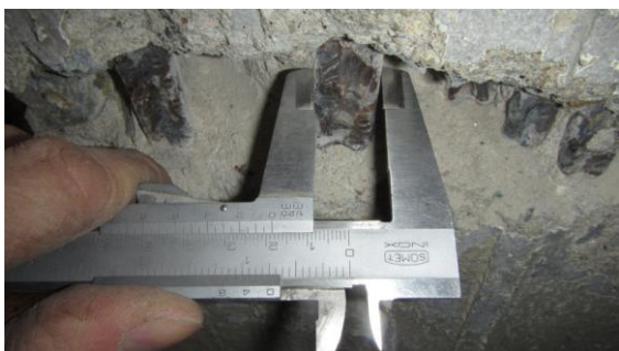
Obrázek 265 Foto měření průměru hlavní výztuže v sondě V - 2
