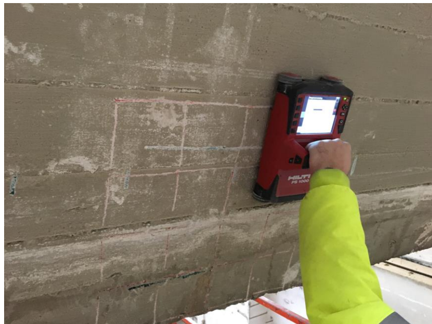
Obrázek 14 Použití georadaru HILTI PS1000 na železobetonovém průvlaku
