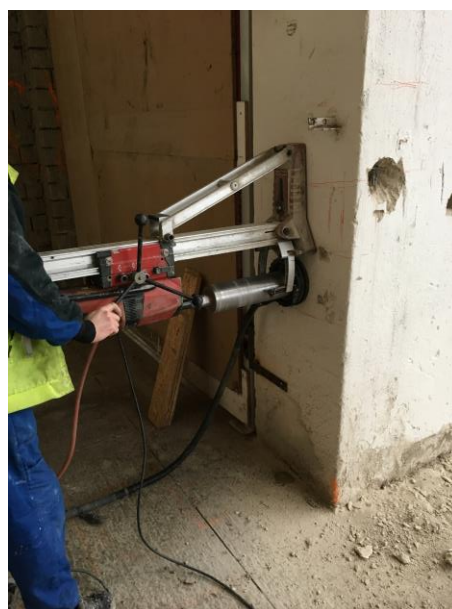
Obrázek 1 Pohled na odběr jádrových vývrtů
