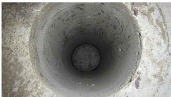
Obrázek 36 Pohled do odebraného jádrového vývrtu ze sloupu M - 7
