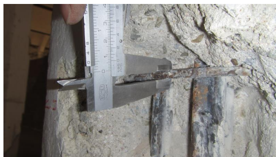
Obrázek 147 Pohled na měření průměru třmínku
