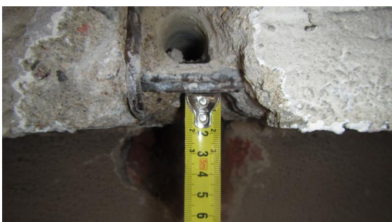
Obrázek 232 Foto měření krycí vrstvy od spodního líce jedné z hlavních výztuží průvlaku
