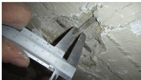
Obrázek 191 Foto měření průměru vodorovné výztuže v sondě D - 2
