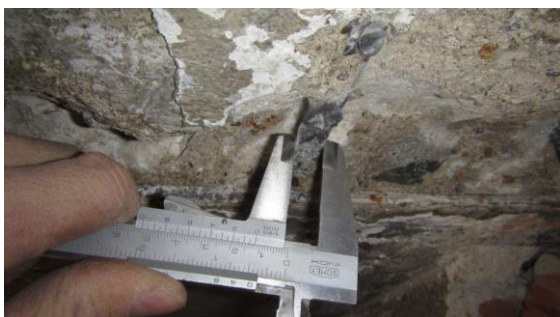
Obrázek 234 Foto měření průměru hlavní výztuže v sondě P - 4
