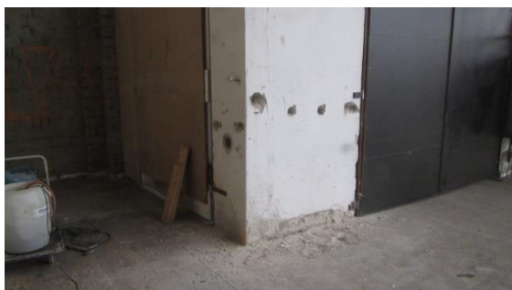
Obrázek 34 Pohled na sloup M - 7 s odebraným jádrovým vývrtem
