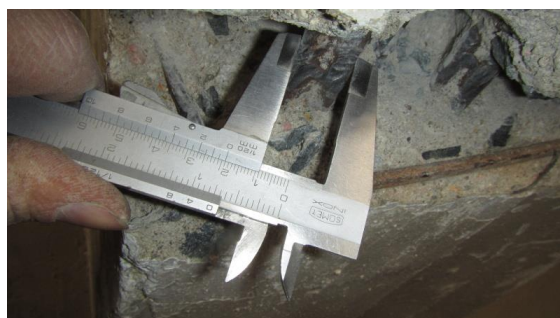
Obrázek 241 Foto měření průměru jedné z hlavní výztuže v sondě Ž - 1
