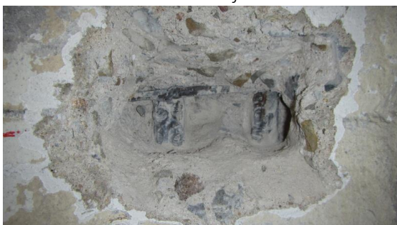
Obrázek 150 Foto sekané sondy na kratší straně sloupu M-7
