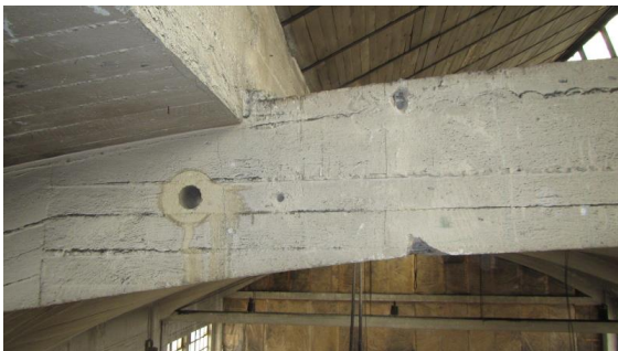
Obrázek 267 Pohled na obloukové žebro s provedenou sekanou sondou Ž – 3 a jádrovým vývrtem V16 v úseku mezi sloupy N7 – M7
