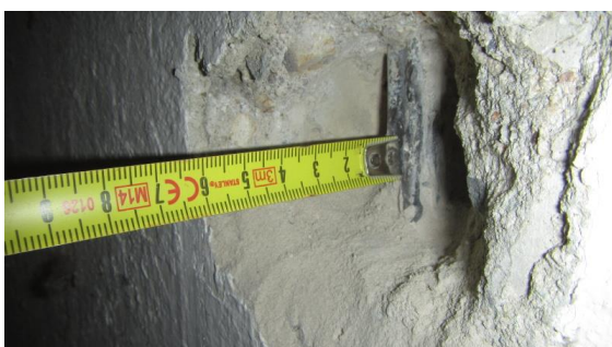
Obrázek 160 Foto tloušťky krycí vrstvy na kratší straně sloupu P-8 v sondě P-8.1
