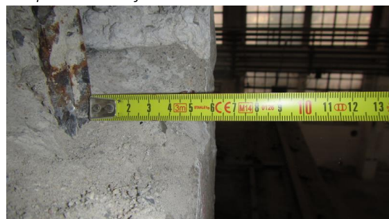
Obrázek 151 Foto měření krycí vrstvy na delší straně sloupu M-7 v sondě M-7.2
