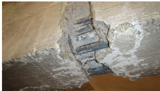
Obrázek 292 Bližší foto zkoumaného táhla s provedenou sekanou sondou při spodním líci
