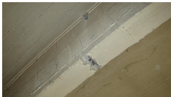
Obrázek 284 Bližší foto zkoumaného žebra s provedenou sekanou sondou
