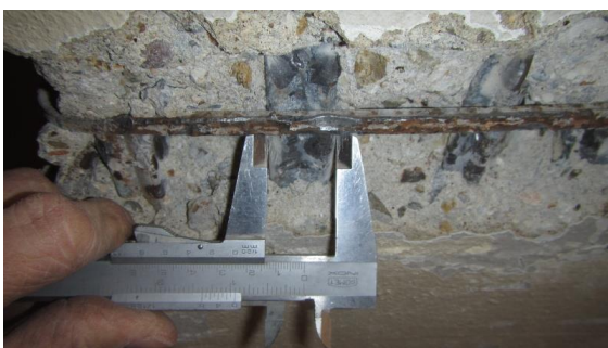
Obrázek 226 Foto měření průměru hlavní výztuže v sekané sondě P - 3
