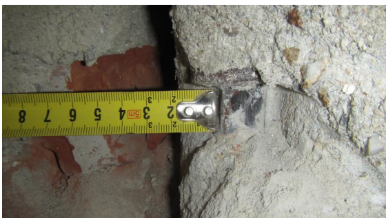
Obrázek 136 Foto tloušťky krycí vrstvy na rohu sloupu F-9
