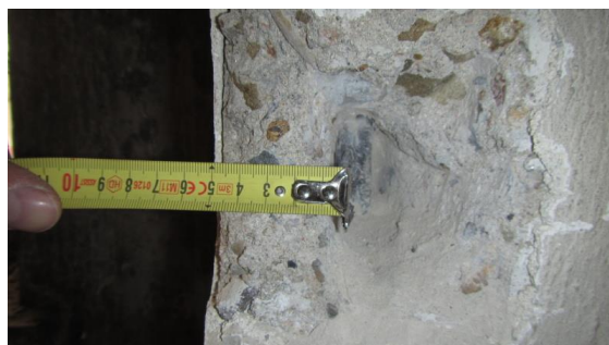
Obrázek 175 Foto měření krycí vrstvy na kratší straně sloupu P-8 v sondě P-8.3
