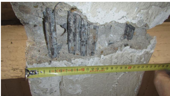
Obrázek 269 Měření šířky obloukového žebra s odkrytou krycí vrstvou hlavní výztuže na spodním líci
