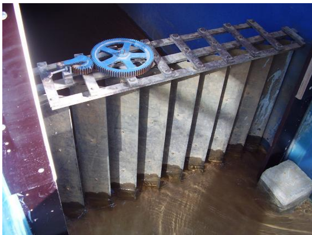
Obr. 6.4 Žaluziová hradicí konstrukce
