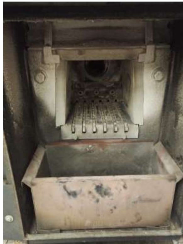
Obr.3.4 Kotlové těleso s roštem
