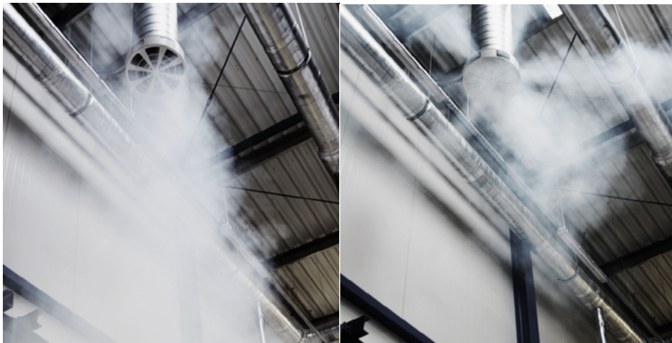
Obrázok 27 - režim a) vykurovanie b) chladenie [31]
