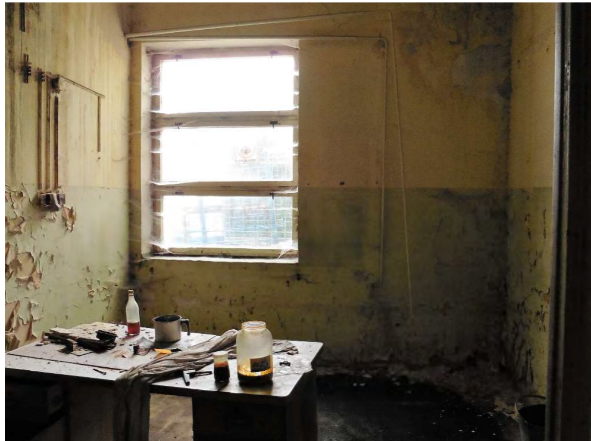
◀ dochované chátrající stavby bývalého zázemí a skladů dokumentace navazující na haly výroby; nižší světlá výška, pultové střechy ▶
