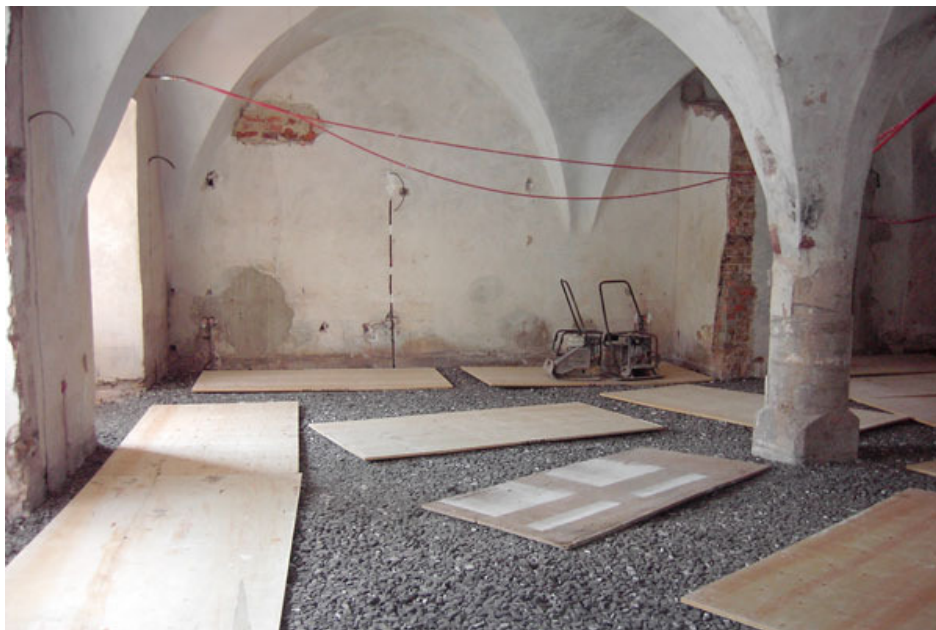
Obr.17 Využití drti z pěnoskla u rekonstrukcí historických objektů
