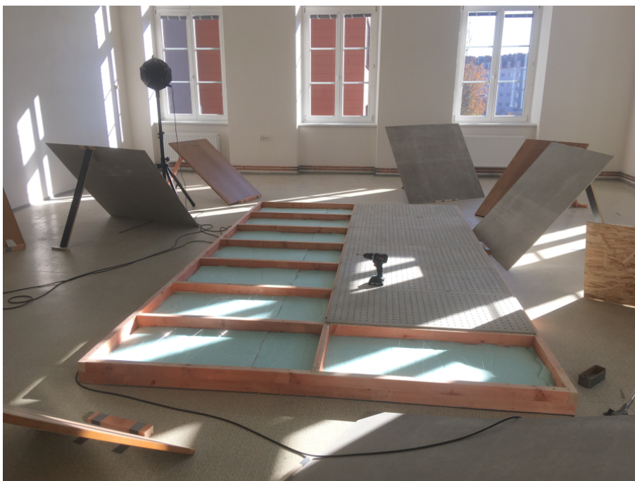
Obr. B.23: Izolant umístěný do rámu. [autor]
