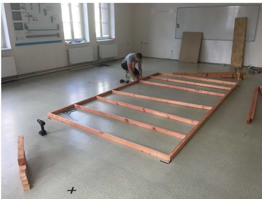
Obr. B.11: Výroba rámu pro měření. [autor]
