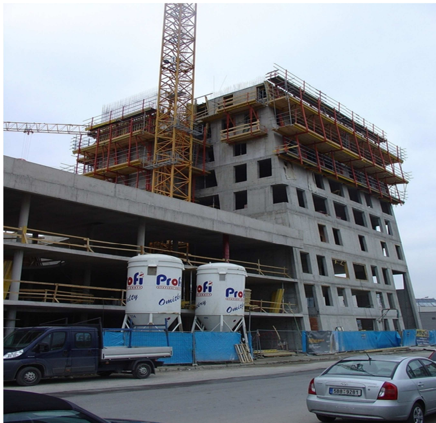
Stavba výškové budovy, šplhavé lešení
