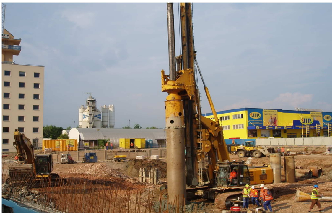
Budování základů – piloty
