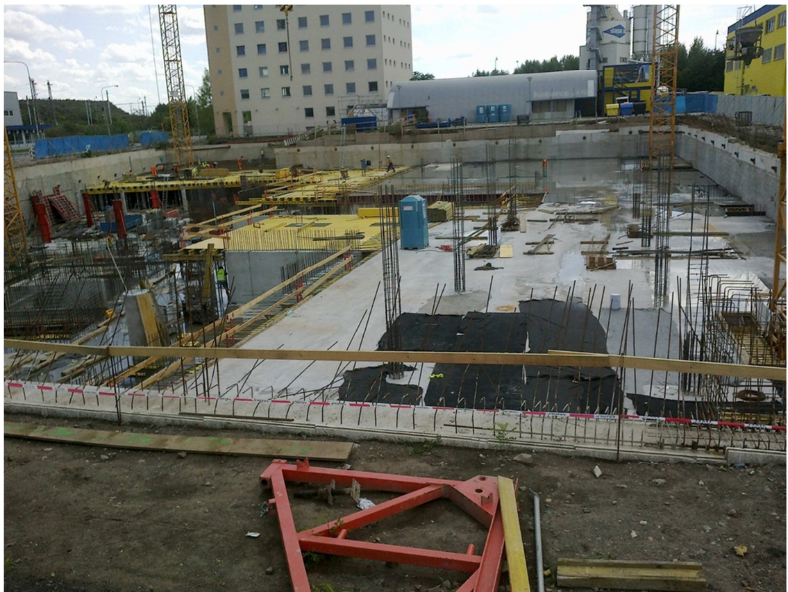
Budování druhého podzemního podlaží, 4 stojící jeřáby
