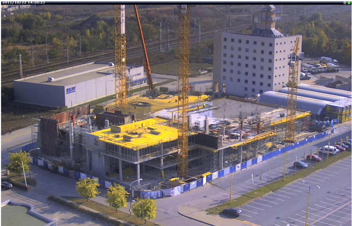
Pohled na staveniště z webkamery
