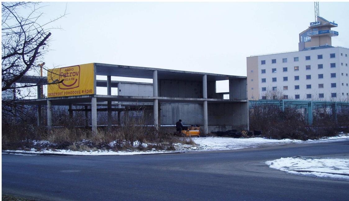
Nedostavěný skelet na pozemku budoucího objektu AZ Tower
