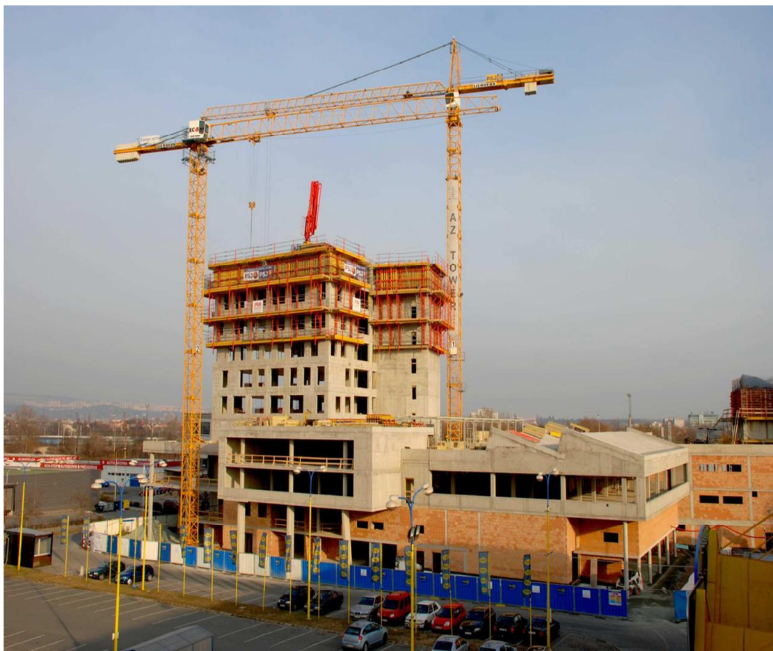
Pohled na stavbu
