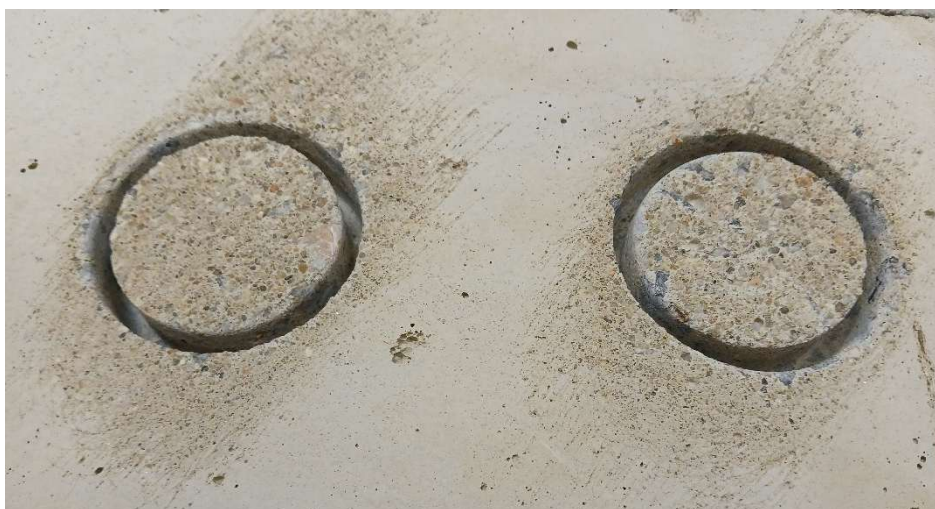
Obr. 6 Povrch bloku z betonu R při čištění ocelovým kartáčem
