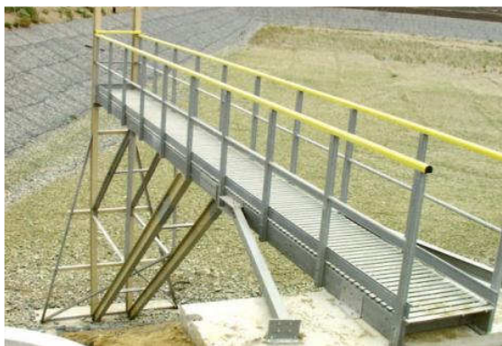
Obr.2.2 Nosná konstrukce lávky, 2000 47
