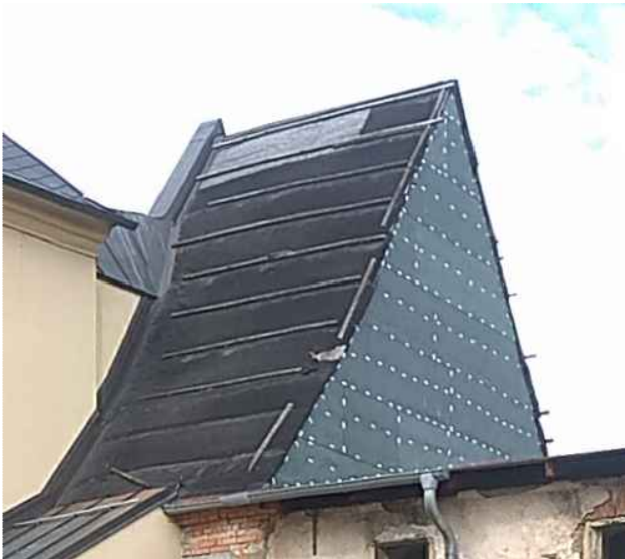
Obr. 2 - Fotografie zakonzervované sekce původních krovů
