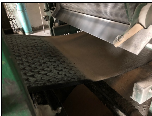
Obr. č. 13: Výroba asfaltového pásu – nanášení minerálního posypu
