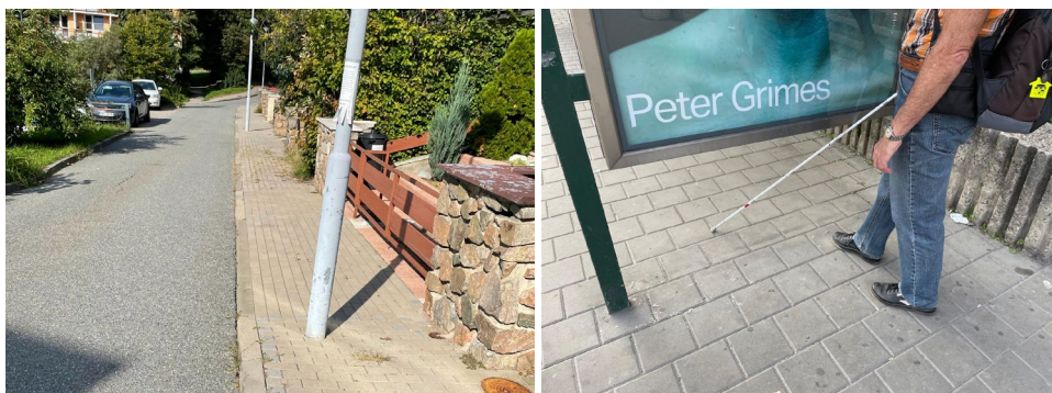
Obr. 22. Pevné překážky na chodníku
