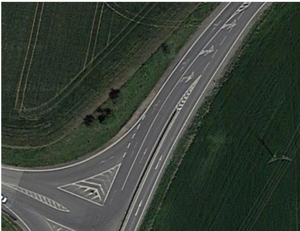
Obr. 20. Styková křižovatka s vloženým středním připojovacím pruhem na křižovatce sjezdu z dálnice D 8 a silnice I/9 severně od Prahy, zdroj: Mapy.cz
