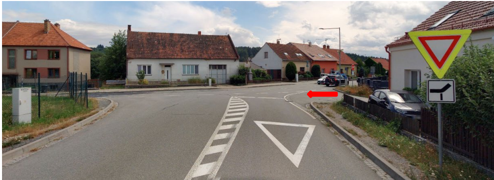
Obr. 8. Zvýšení postřehnutelnosti křižovatky vodorovným a svislým dopravním značením (křižovatka v obci Březina u Křtin), červená šipka zprava naznačuje připojení komunikace, která není na svislé dopravní značce vyznačena, zdroj: Mapy.cz
