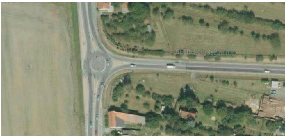
Obr. 17. Úprava křižovatky silnic I/43 a II/379 v obci Lipůvka jako okružní křižovatky, zdroj: Mapy.cz
