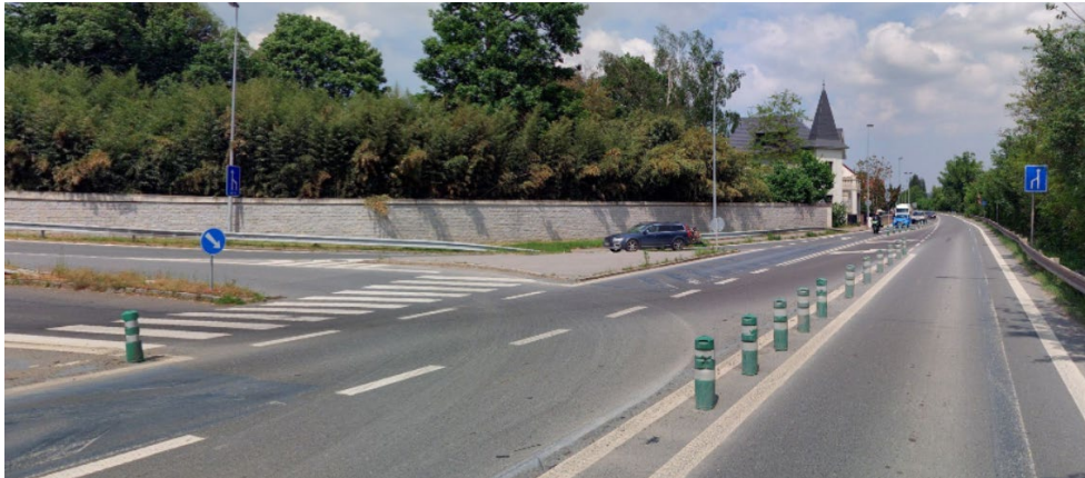
Obr. 19. Styková křižovatka s vloženým středním připojovacím pruhem na ulici K Přehradám na sjezdu z mostu Závodu míru na jihu Prahy, zdroj: Mapy.cz
