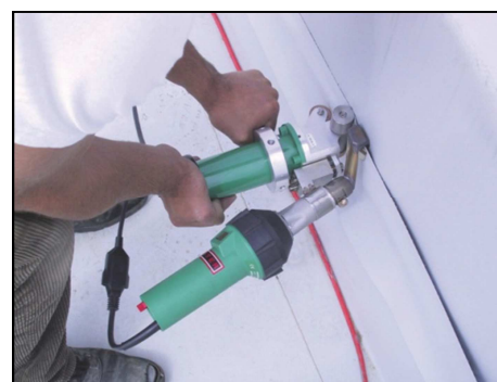
Obr. 6-16 Ruční svářecí poloautomat Leister TRIAC DRIVE PID
