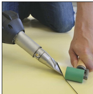
Obr. 6-17 Ruční svářecí pistole Leister TRIAC S
