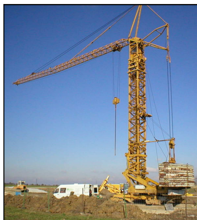
Obr. 6-1 Věžový jeřáb MB1030.1
