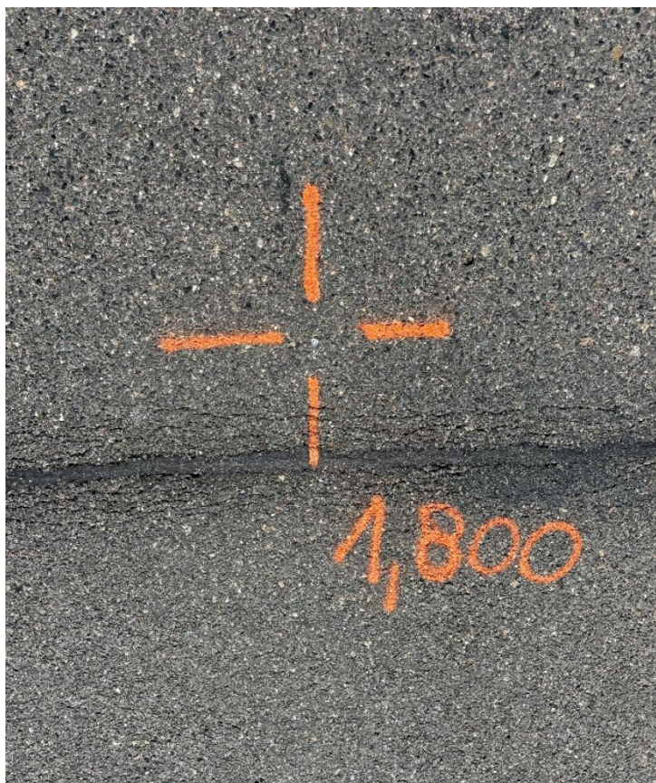
Obrázek 13: Ukázka stabilizace osy komunikace v km 1,800
