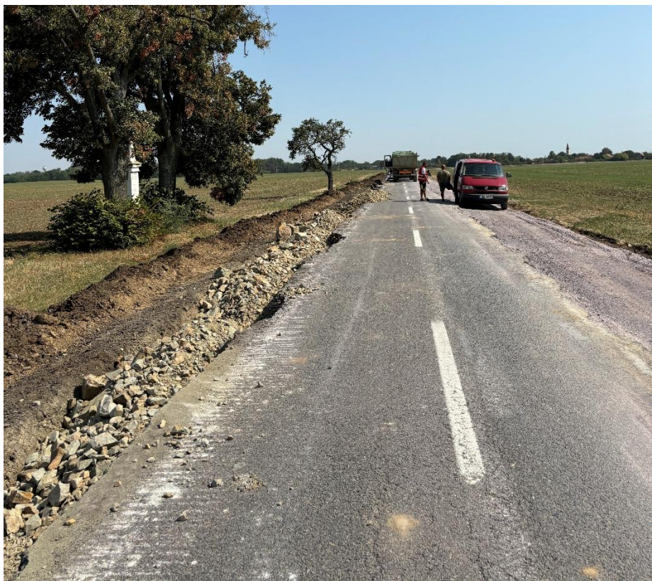
Obrázek 15: Dokončená sanace krajnice – vpravo
