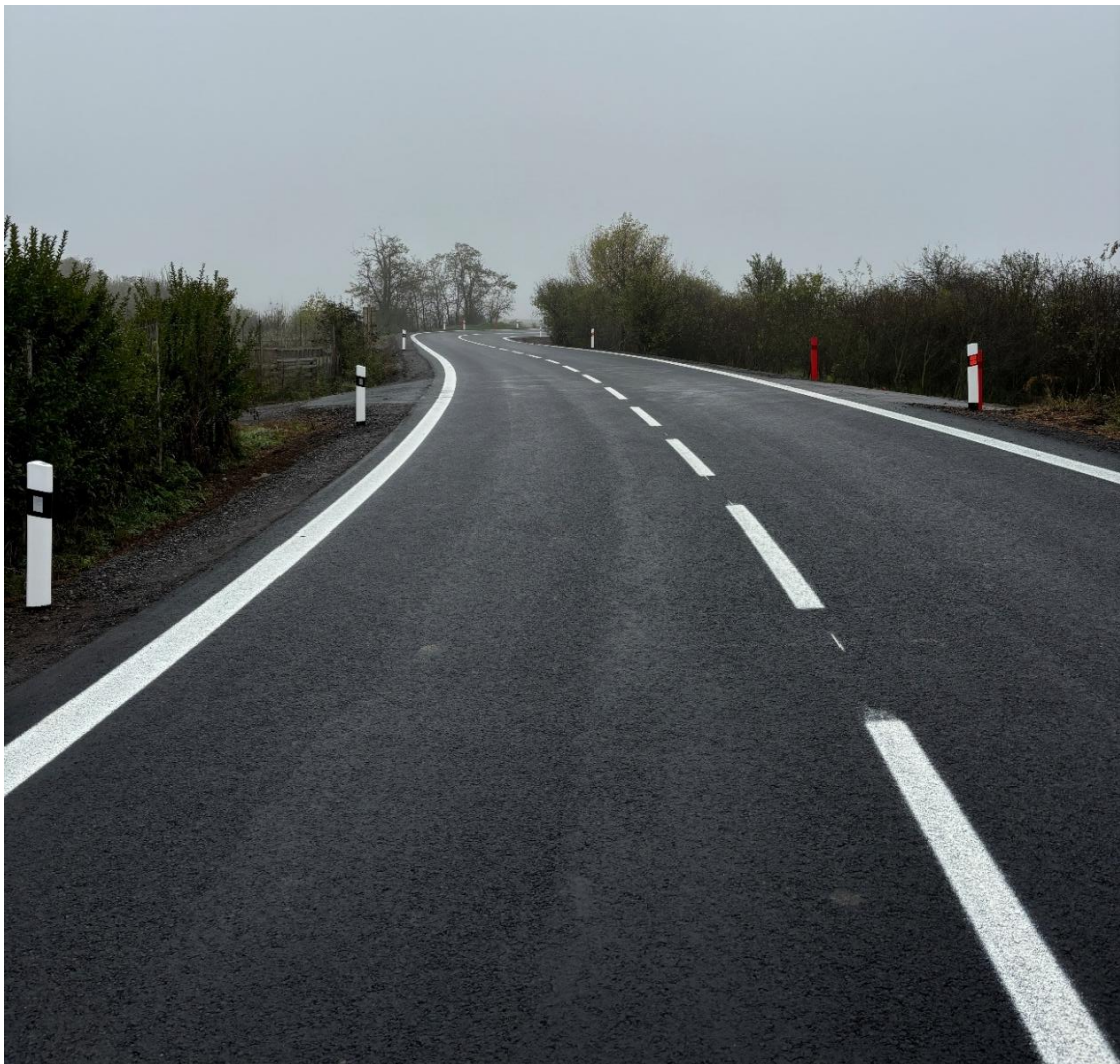
Obrázek 26: Ukázka dokončené rekonstrukce
