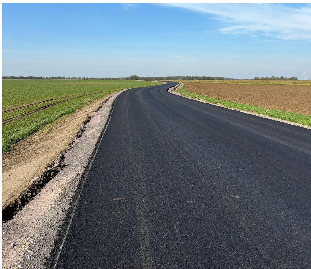
Obrázek 19: Dokončená pokládka ložní vrstvy ACL 16+
