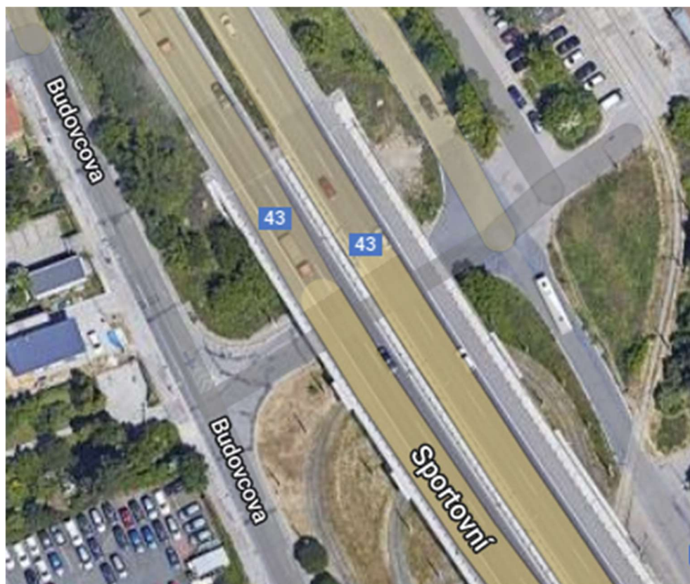
Obrázek 50 – Podjezd směřující na ulici Budovcova [2]
