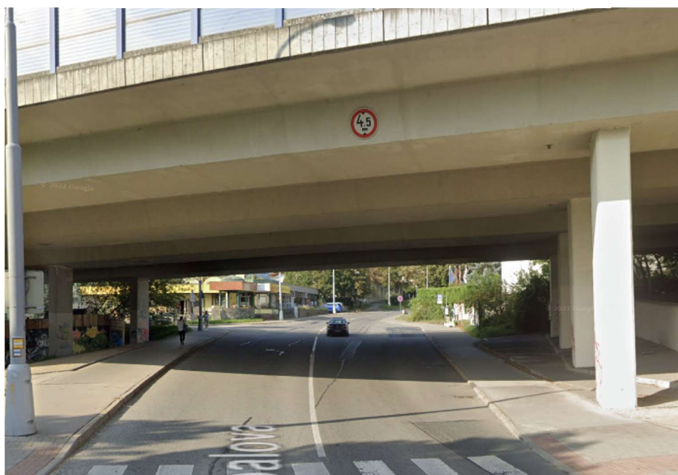
Obrázek 66 – Podjezd na ulici Hapalova [2]
