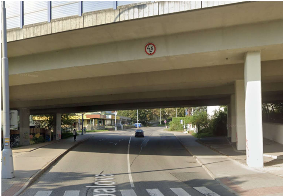
Obrázek 43 – Podjezd na ulici Hapalova [2]
