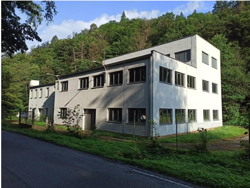
Obr. 5.1 Úpravna vody Josefov
