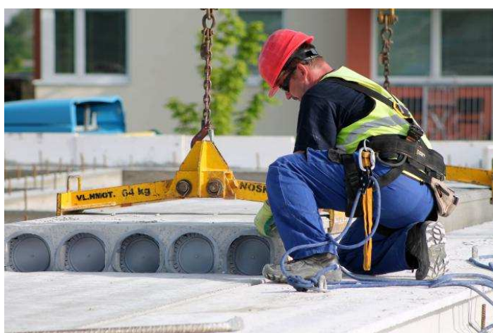
Obr. 87 Montáž stropních panelů [44]
