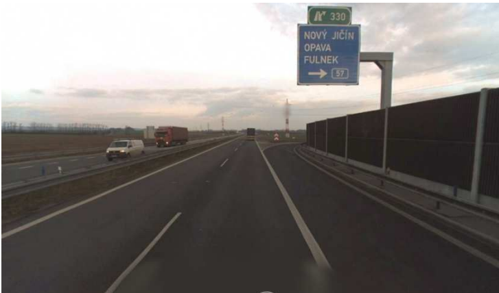
Obr. 11 Detail sjezdu z dálnice D1 [1]
