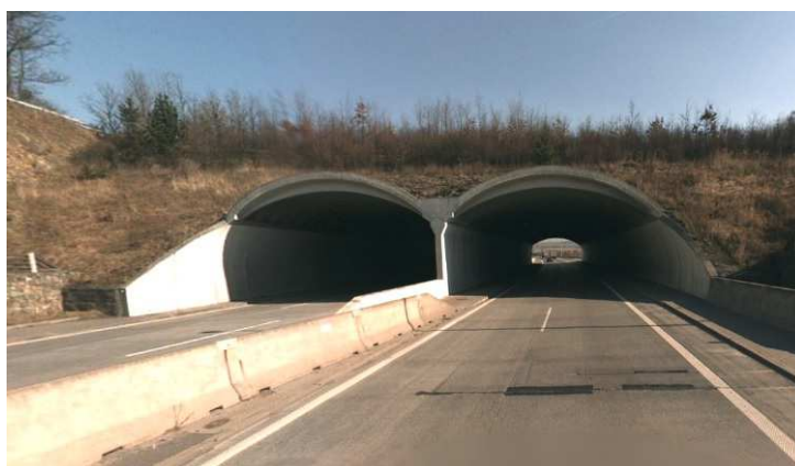
Obr. 9 Detail tunelu na dálnici D35 [1]
