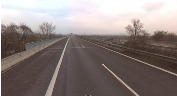
Obr. 10 Detail přejezdu mostem na dálnici D1 [1]
