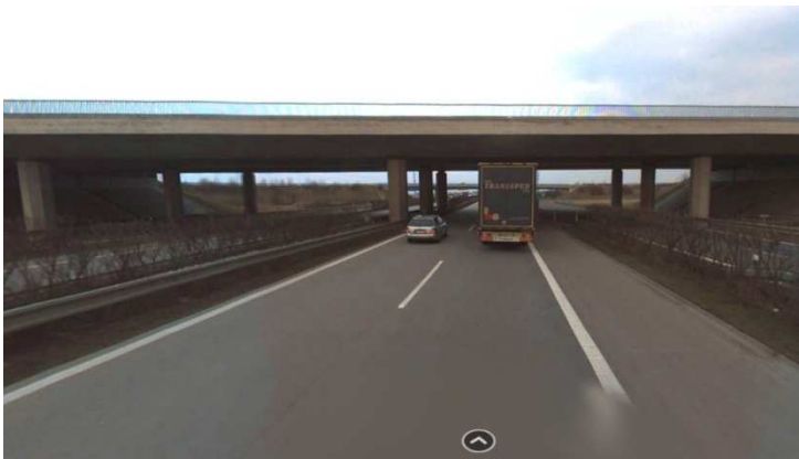
Obr. 8 Detail podjezdu pod mostem na dálnici D1 [1]
