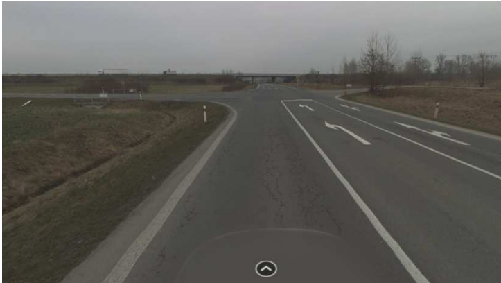
Obr. 7 Detail nájezdu na dálnici D35 [1]
