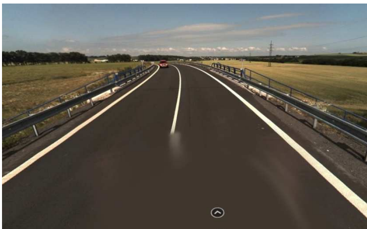
Obr. 15 Detail přejezdu mostem přes železniční trať [1]
