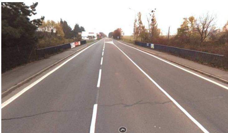
Obr. 13 Detail přejezdu mostem přes železniční trať [1]
