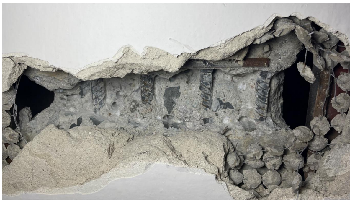
Obr. 52: Prievlak sondy A5 obsahujúci hlavnú pozdĺžnu výstuž \varnothing 14 (10 400 – R40) mm. V mieste okrajových prútov navarené pásoviny, podobne ako u sondy, držiace podhl'ad.
