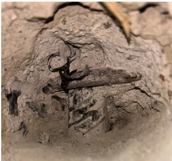
Obr. 29: Sekaná sonda stĺpa A1, hlavná výstuže R40.
