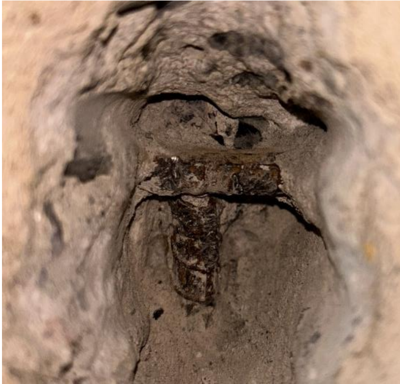
Obr. 39: Hlavná stredová výstuž stĺpa A3, \varnothing 12 mm R30, z dlhšej strany stĺpa (750 mm). Strmienka \varnothing 10 mm R40.
