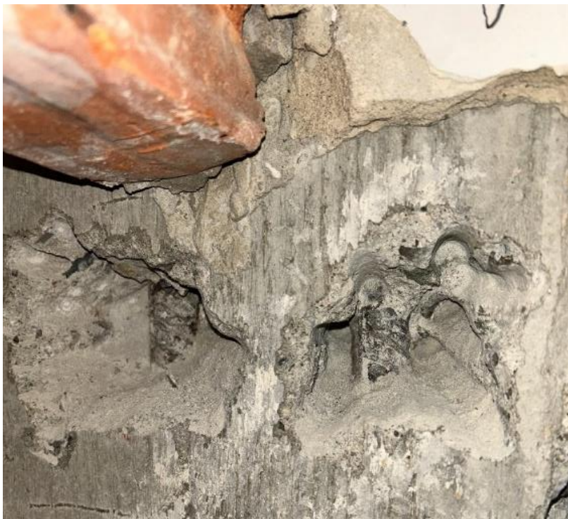
Obr. 40: Hlavná stredová výstuž stĺpa A3, \varnothing 25 mm R40, z kratšej strany stĺpa (400 mm).
