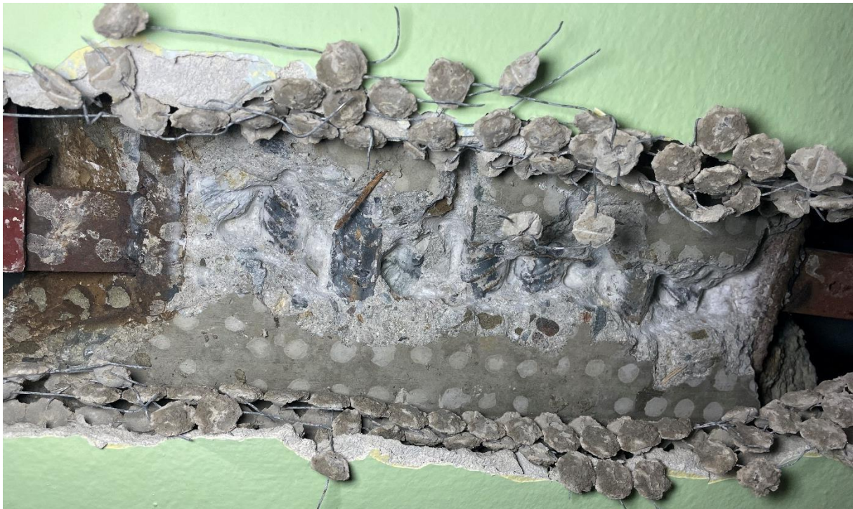
Obr. 46: Prievlak sondy A4 obsahujúci hlavnú pozdĺžnu výstuž \varnothing 25 (10 400 – R40) mm. V mieste okrajových prúťov navarené pásoviny držiace podhlad tvorený rabicovým pletivom, betónovými vločkami a omietkou.
