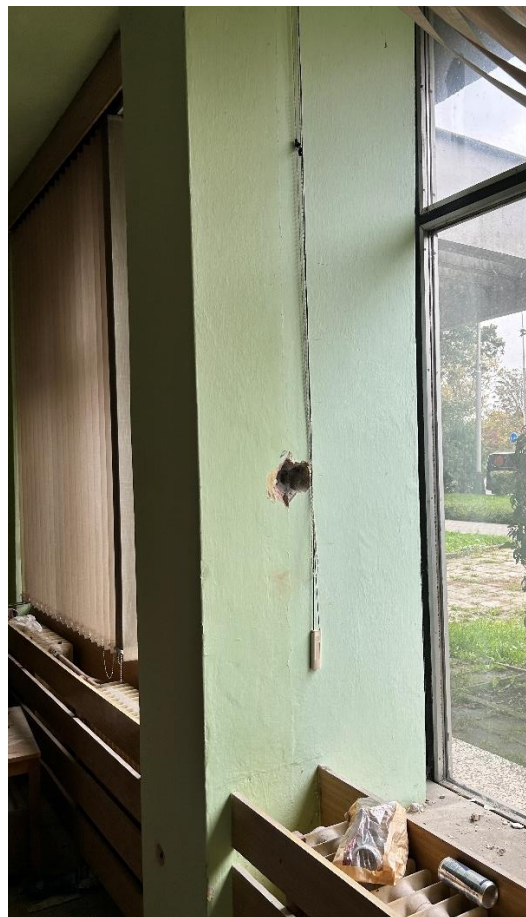
Obr. 34: Pohľad na vonkajší stĺp A2.
