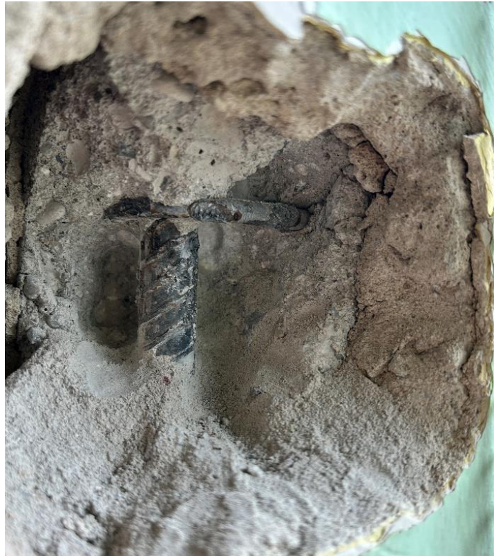
Obr. 35: Výstuž stĺpa A2 Ø 12 mm R40, strmienka hladká kruhová výstuž Ø 6 mm.
