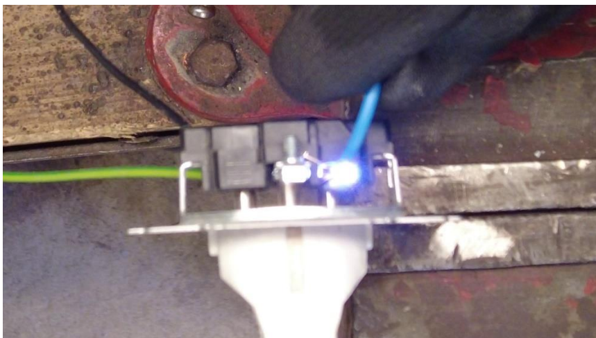
Obrázek 6.8: Vznik oblouku kvůli nedostatečně utažené šroubové svorce
