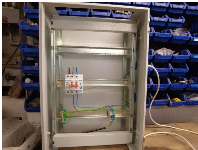
Obrázek 6.1: Zapojení rozváděče
