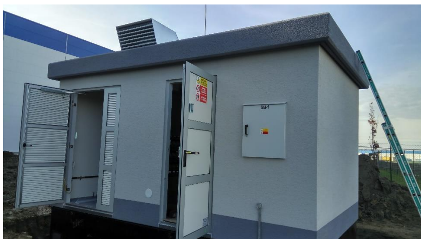
Příloha 3: Pokládání trafostanice (vlastní zpracování)
