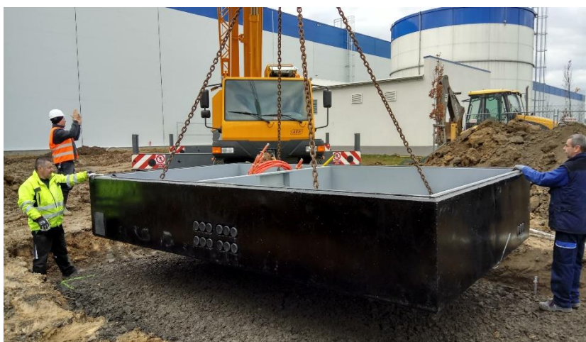
Příloha 1: Pokládání trafostanice (vlastní zpracování)
