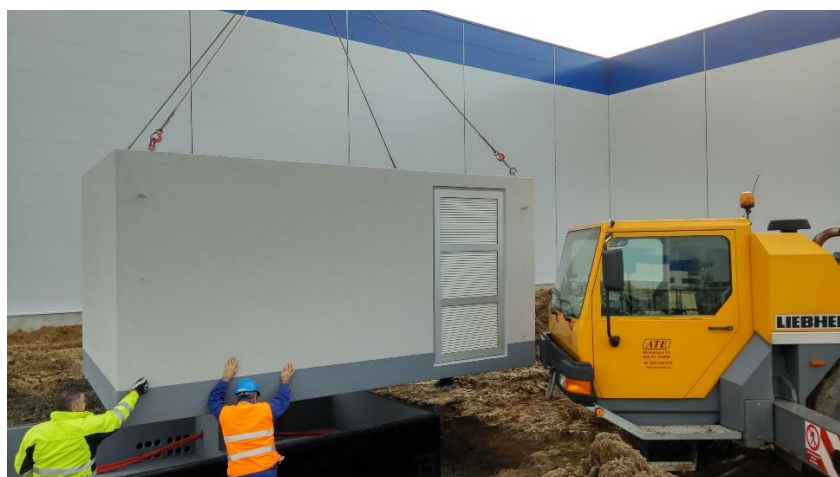
Příloha 2: Pokládání trafostanice (vlastní zpracování)
