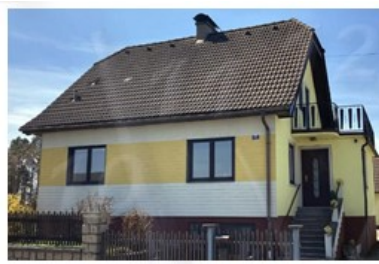
Obrázek č. 11 – Stavba č. 3
