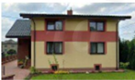
Obrázek č. 10 – Stavba č. 2
