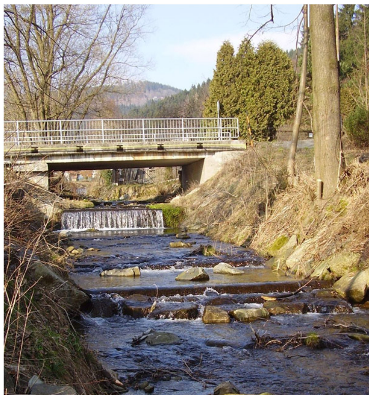
Obrázek 6.2: Dřevěný spádový stupeň [8]
