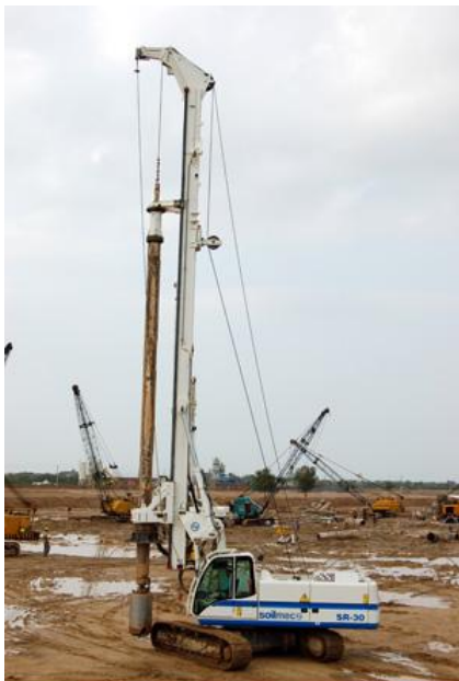
Obr. 26. Vrtná souprava Soilmec SR-30:
