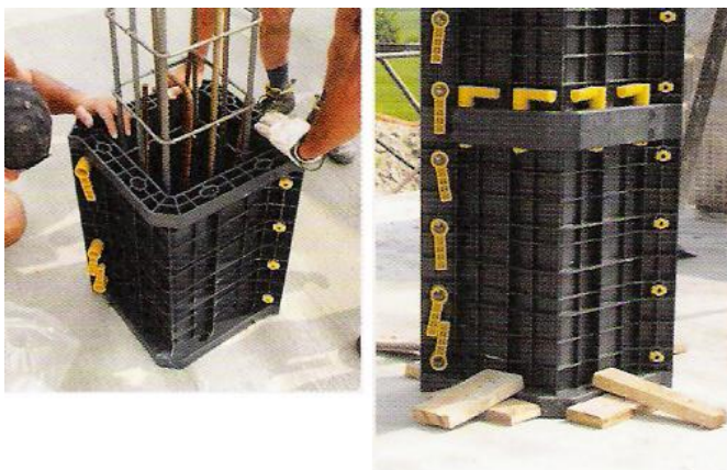
Obr. 10. Plastové bednění GEOTUB PANEL 45:
