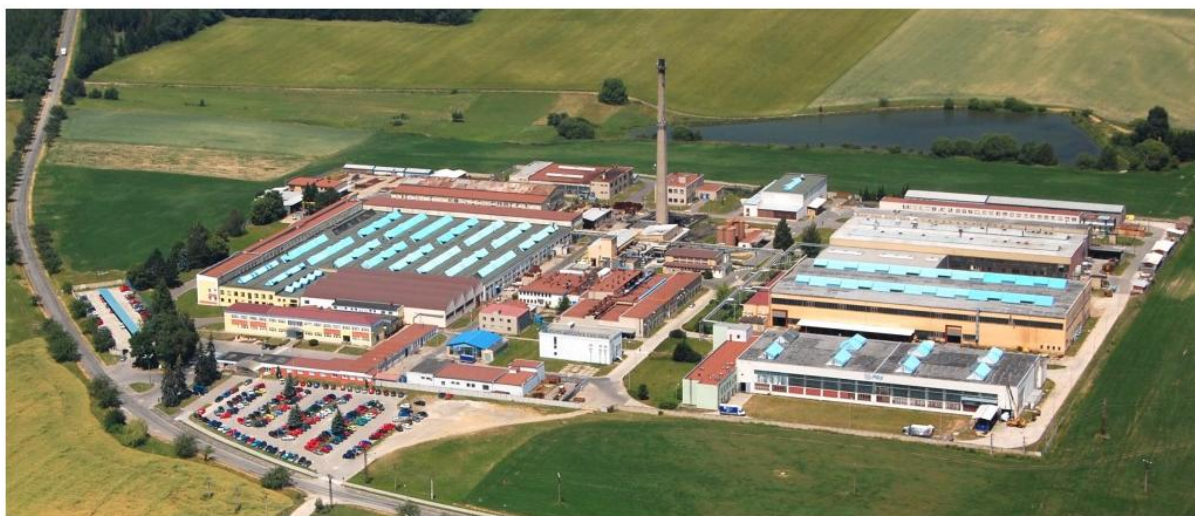
Obr. 5: Letecký pohled na areál PBS Velká Bíteš, a.s. [16].
