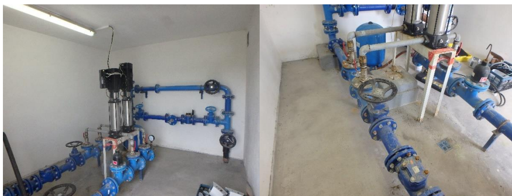
Obr. 4.3 Objekt ATS Hvozdná pro tlakové pásmo T1
