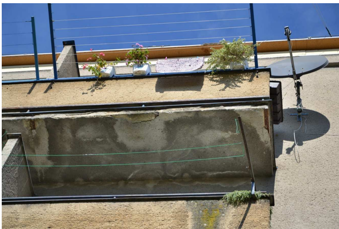
Obr. 13: Balkon ve 4. NP na jižní fasádě.
