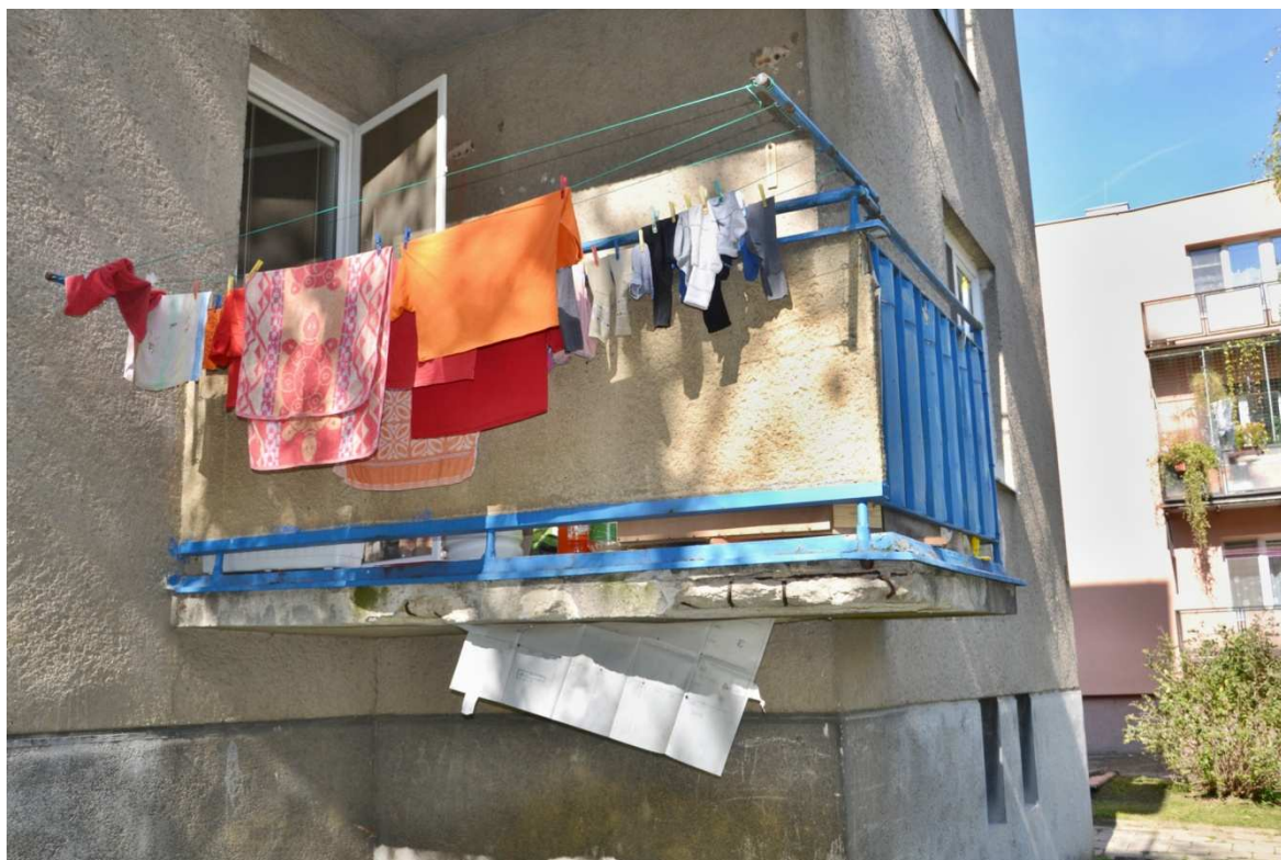
Obr. 16: Balkon v 1. NP na východní fasádě objektu.
