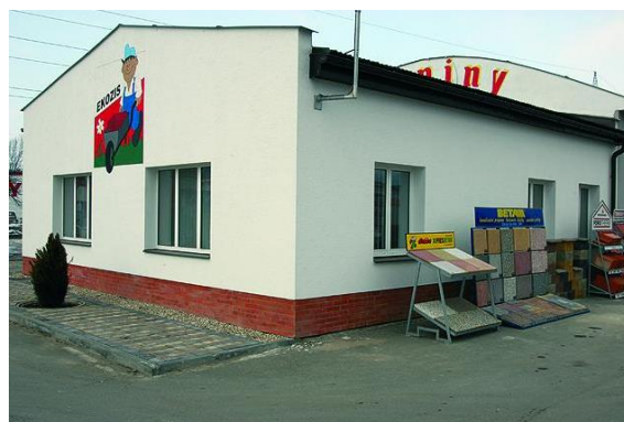
Obrázek 8: Prodejna stavebnin Šumperk (Zdroj: (17))
