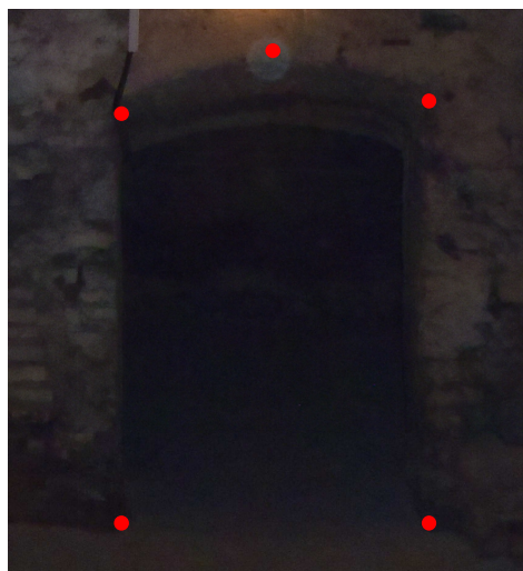
Obr. 19 Zaměření dveřního otvoru
