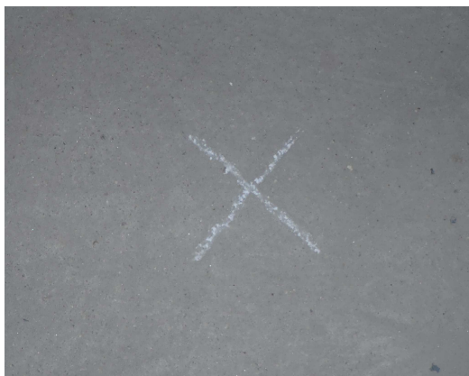
Obr. 12 Ukázka dočasné stabilizace
