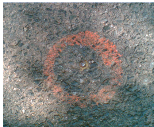
Obr. 13 Ukázka trvalé stabilizace
