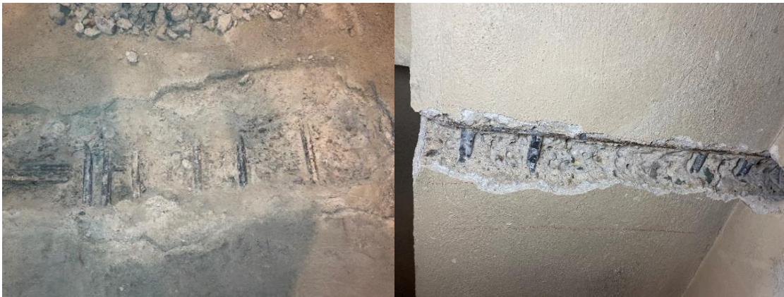
Obr. 4: Sekané sondy – podlaha (vlevo), průvlak (vpravo)
