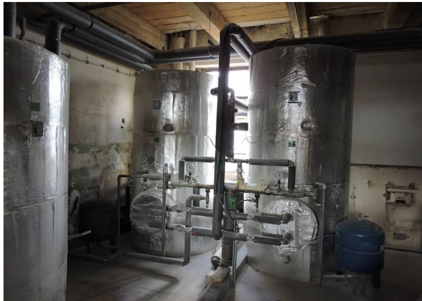
Obr. 27 Zapojení zásobníků TUV
