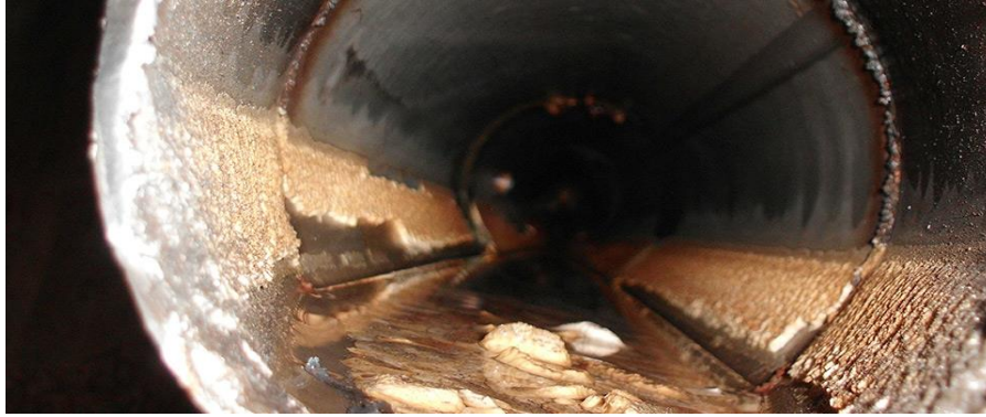
Obr. 10 Zanesení parního potrubí [13]
