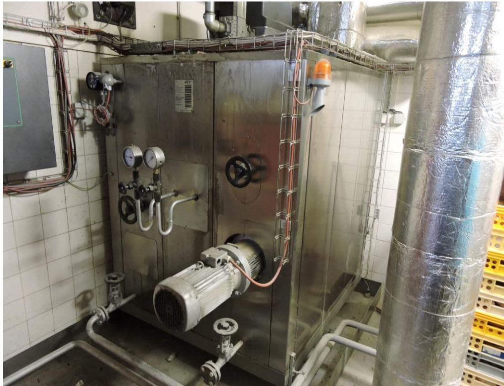
Obr. 19 Termoolejový kotel
