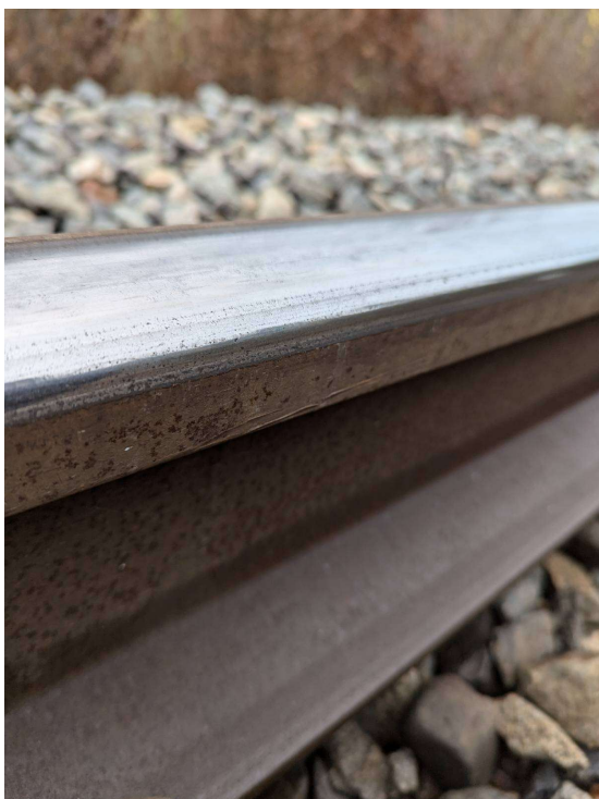
Obrázek 35: Detail ojetí vnější kolejnice [autor]
