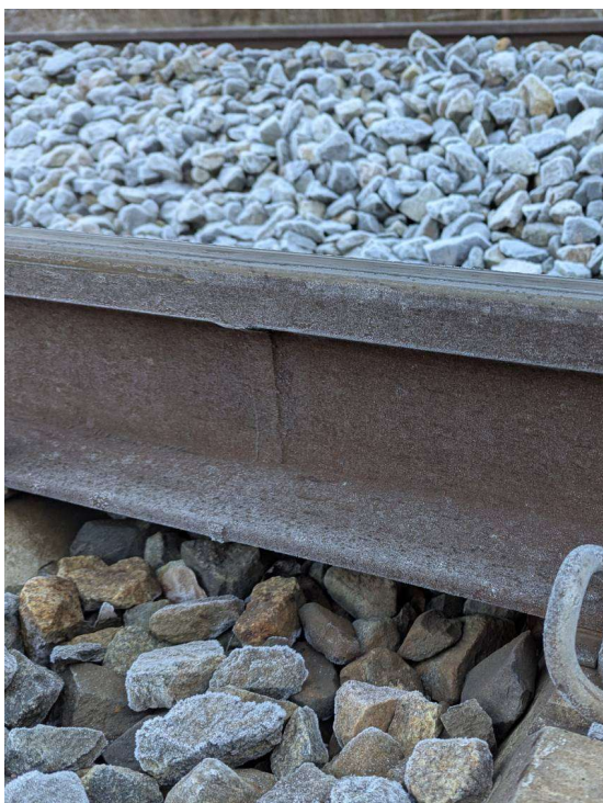
Obrázek 31: Svar pravé (vnitřní) kolejnice v km 168,293 460 [autor]
