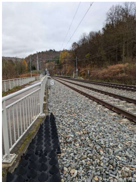
Obrázek 32: Konec měřeného úseku blízko zastávky [autor]
