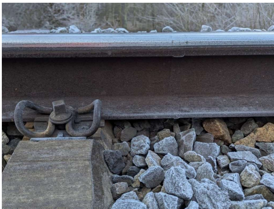
Obrázek 19: Fotka svaru levé (vnější) kolejnice v km 168,293 390 [autor]
