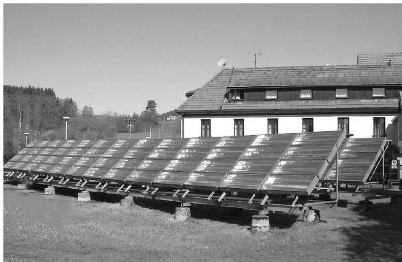
Obrázek 47: Nejstarší dosud funkční systém v Herbertově na Šumavě je v provozu od roku 1982 (koncentračních kolektory) [57]
