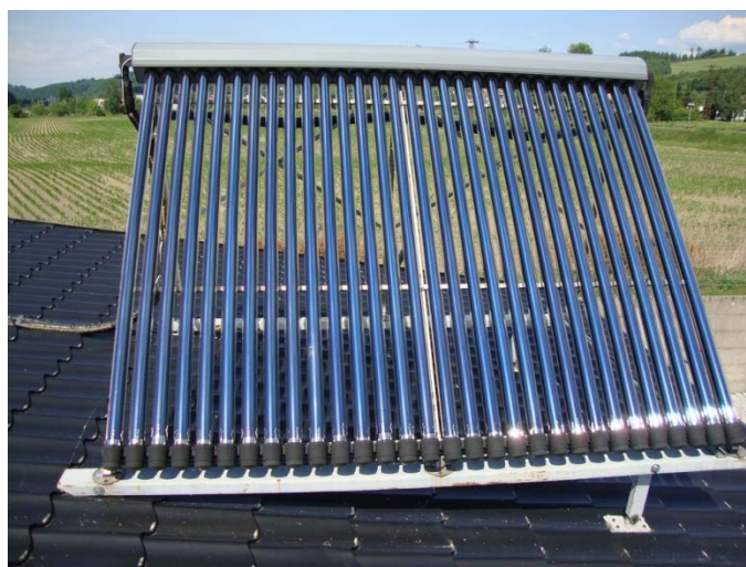
Obrázek 42: Trubkový vakuový kolektor [53]
