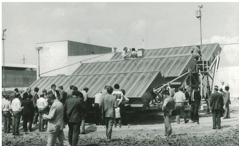
Obrázek 48: Jeden z prvních československých koncentračních kolektorů v chropyňském závodě Státního statku Kroměříž v den exkurze, realizace před rokem 1984, konstrukce umožňovala samonatáčení za Sluncem [58]
