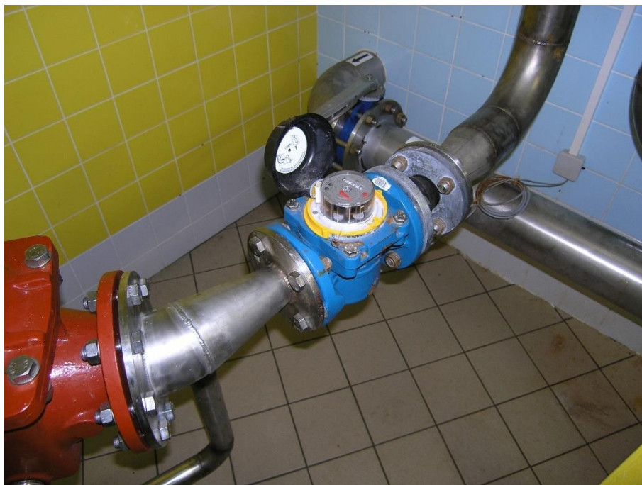
Obrázek 5.12: VDJ Ochoz – nedodržení ukliďovacích délek
