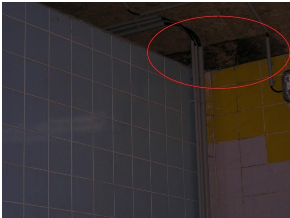
Obrázek 5.5: Stav vnitřních stěn a stropu na ČS Říčka
