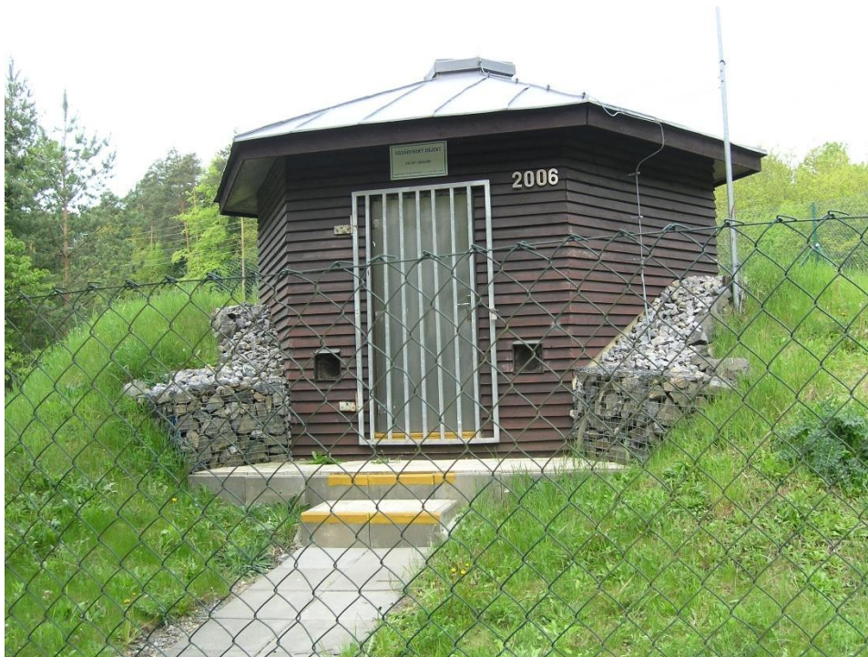
Obrázek 5.11: VDJ Ochoz – zabezpečení vstupu
